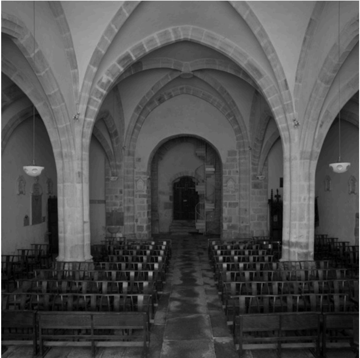
Vue d'ensemble intérieure, vers l'ouest.
