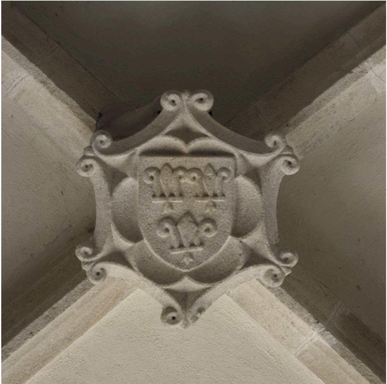
Vue de la clef de voûte n°2 (nef, travée 2).
