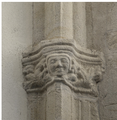
Détail du chapiteau du support le plus au nord de l'abside. Phot. Eric Dessert IVR82_20054201234NUCA
