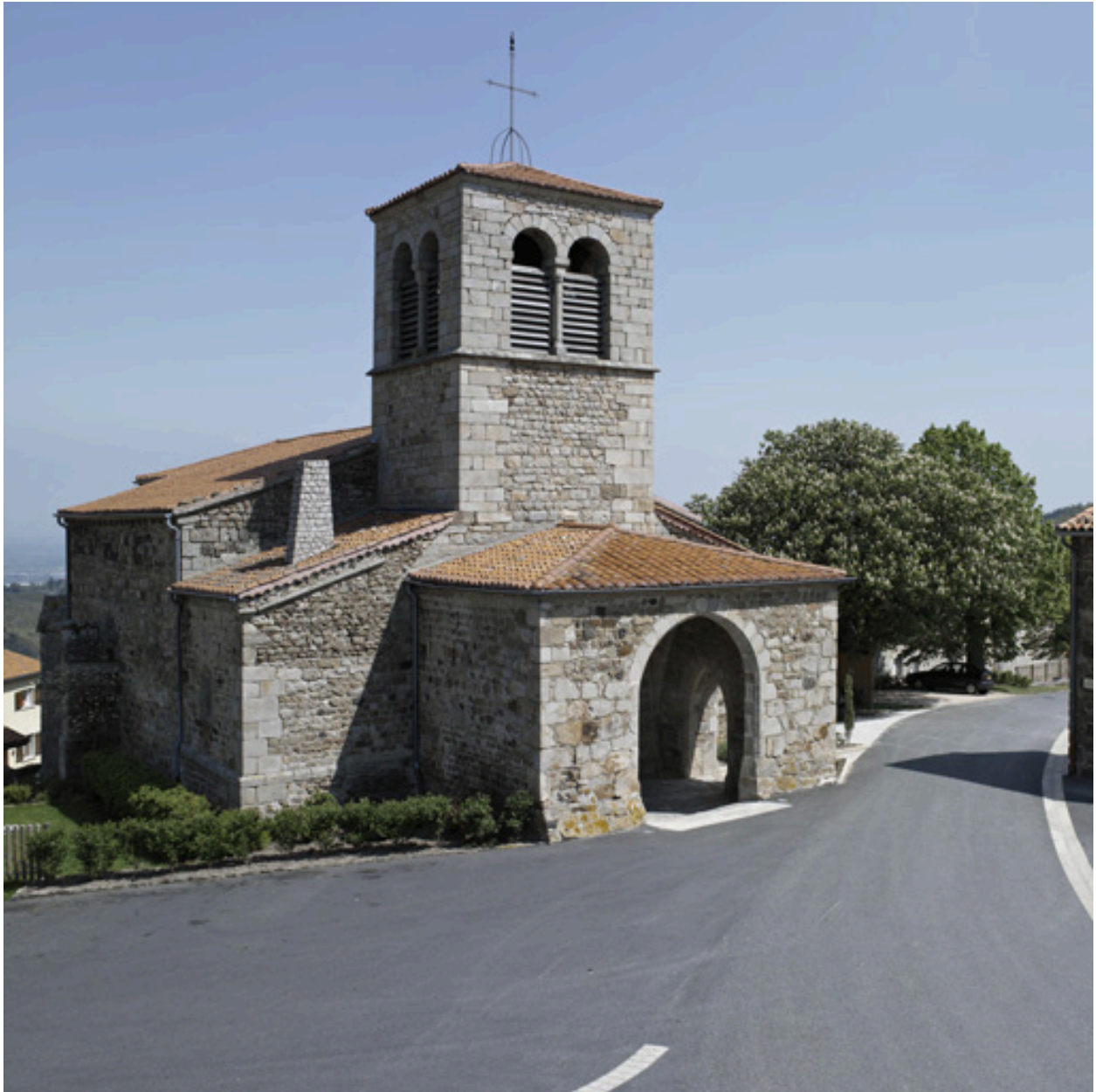
Vue d'ensemble de trois-quarts, depuis le nord-ouest.
