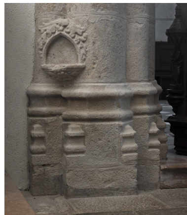
Détail de la base du support nord-ouest du chœur : moulurations prismatiques à tores, bénitier. Phot. Eric Dessert IVR82_20054201238NUCA
