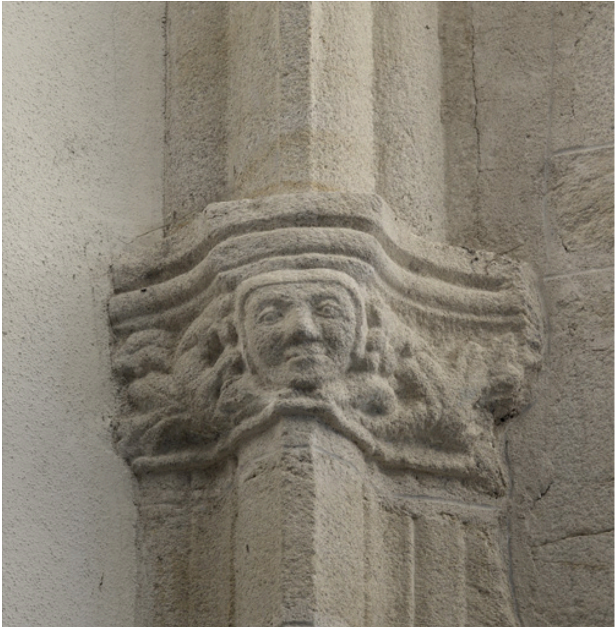
Détail du chapiteau du support le plus au nord de l'abside.
