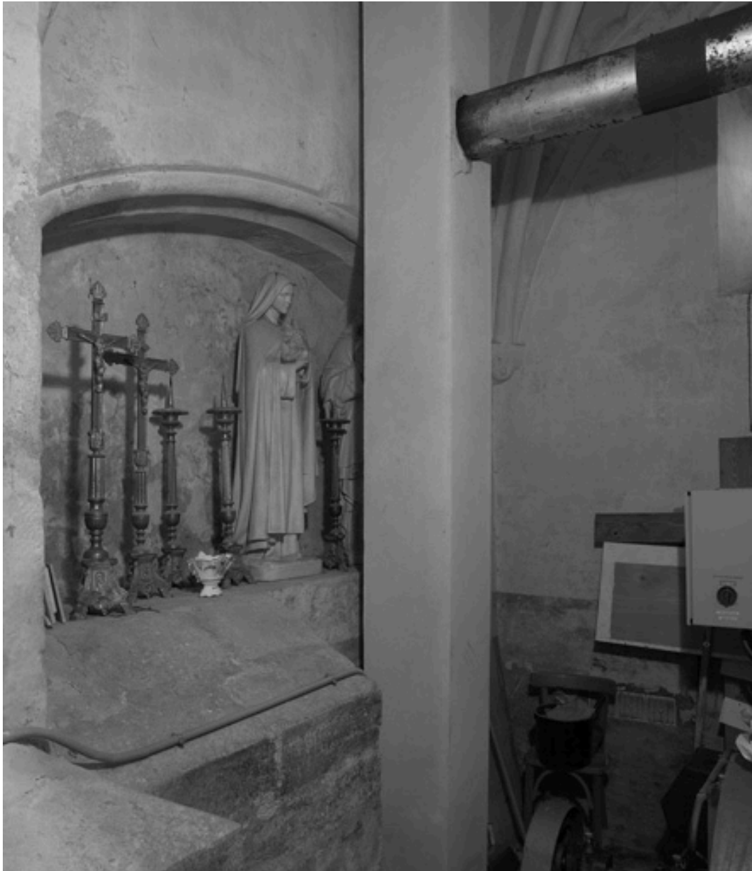
Vue d'ensemble intérieure de la chapelle nord-ouest, transformée en chaufferie.
