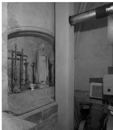
Vue d'ensemble intérieure de la chapelle nord-ouest, transformée en chaufferie. Phot. Eric Dessert IVR82_20054201243NUC
