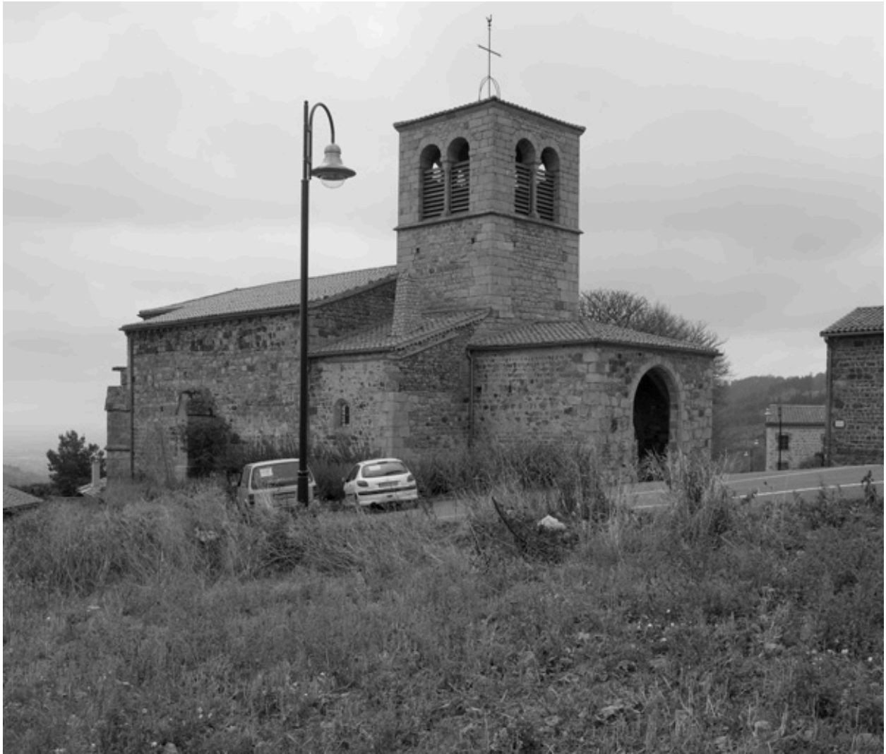
Vue d'ensemble de trois-quarts depuis le nord-ouest.
