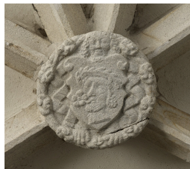
Vue de la clef de voûte n°3 (choeur). Phot. Eric Dessert IVR82_20054201233NUCA
