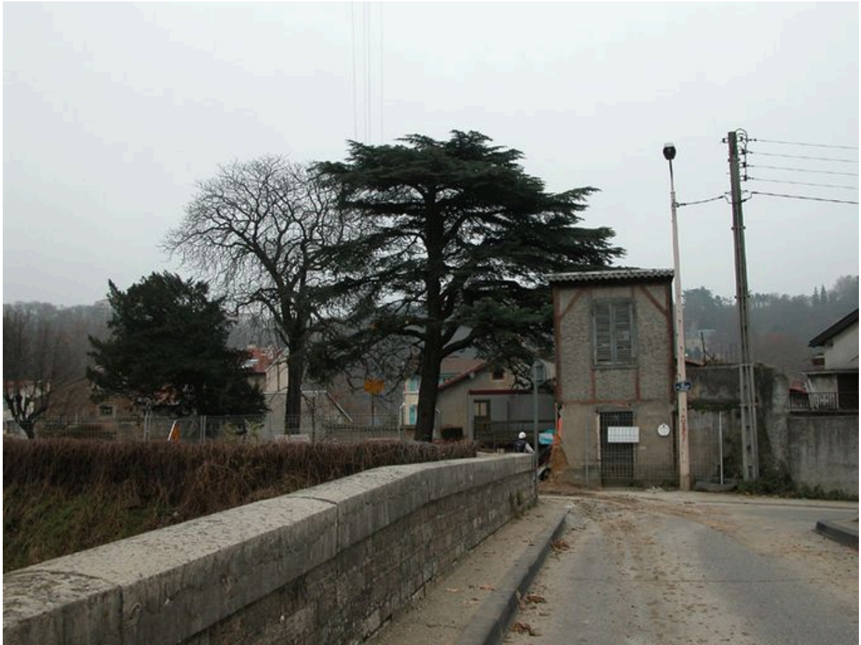
Vue générale depuis le pont de la rue des Docteurs-Cordier
