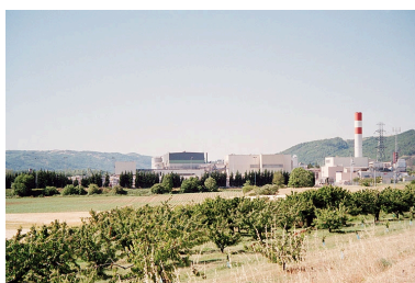
Vue générale nord-ouest Phot. Sébastien Durieu IVR82_20042600098ZE
