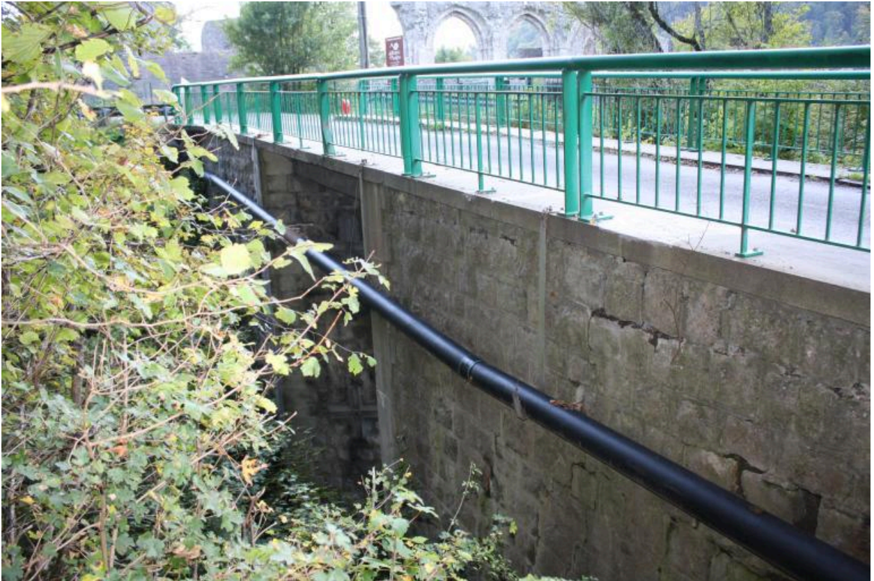
Pont de l'Abbaye, face amont
