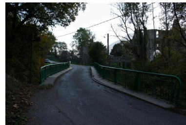
Pont de l'Abbaye, chaussée et gardes corps Phot. Benoît Huraut IVR84_20207401092NUCA
