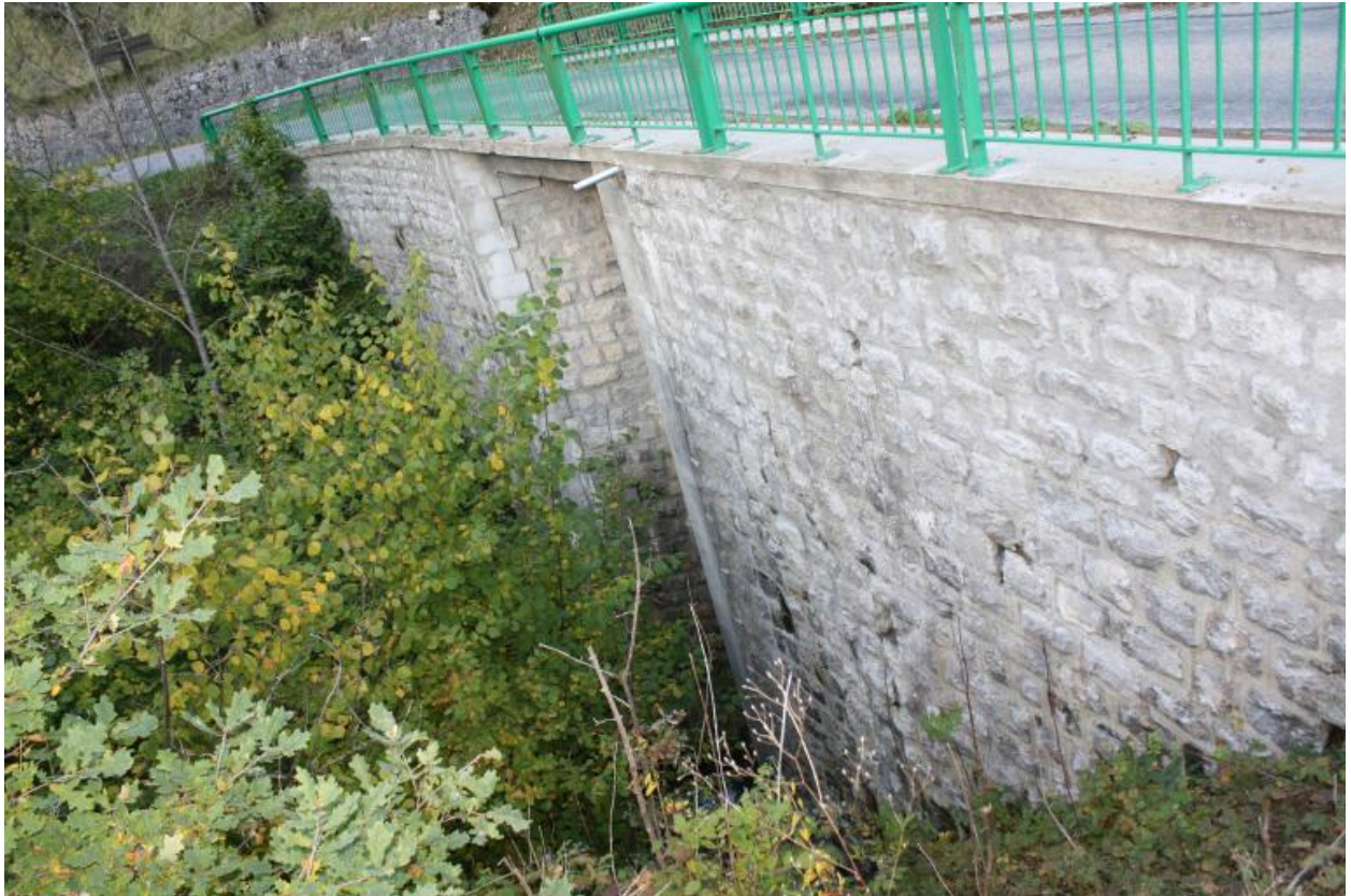
Pont de l'Abbaye, face aval
