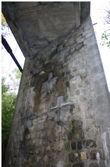
Pont de l'Abbaye, détail culée Phot. Benoît Huraut IVR84_20207401091NUCA
