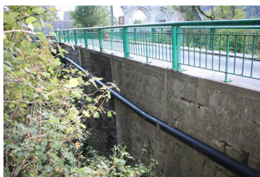
Pont de l'Abbaye, face amont Phot. Benoît Huraut IVR84_20207401094NUCA
