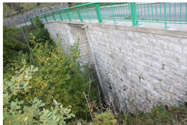
Pont de l'Abbaye, face aval IVR84_20197401276NUCA
