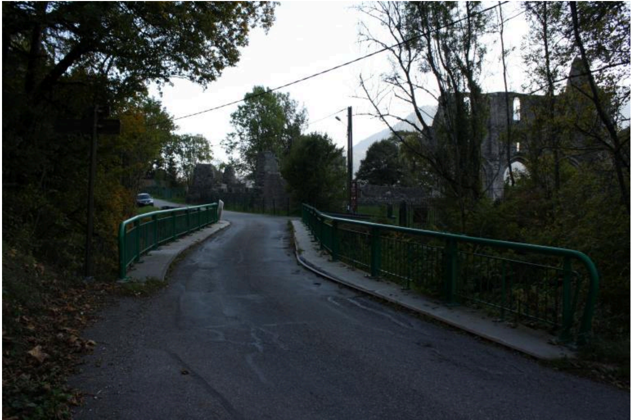
Pont de l'Abbaye, chaussée et gardes corps
