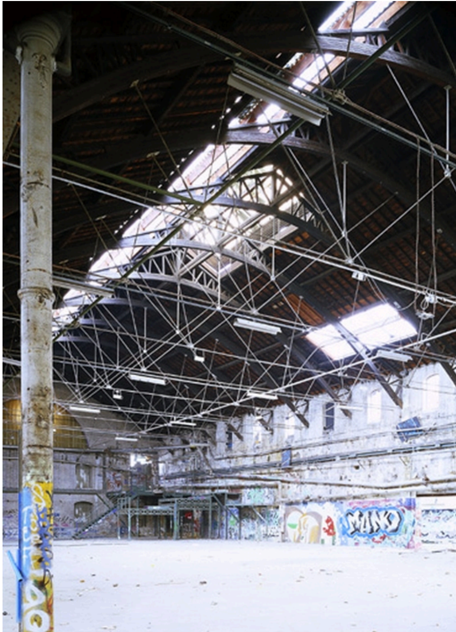
Charpente lamellée collée
