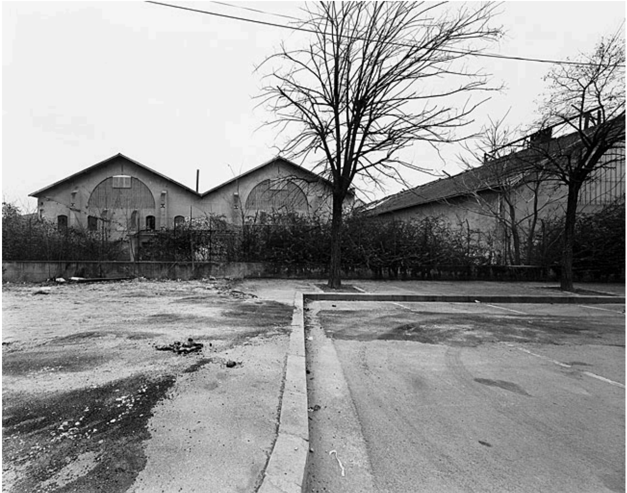
Façade ouest des chais Beaucairois
