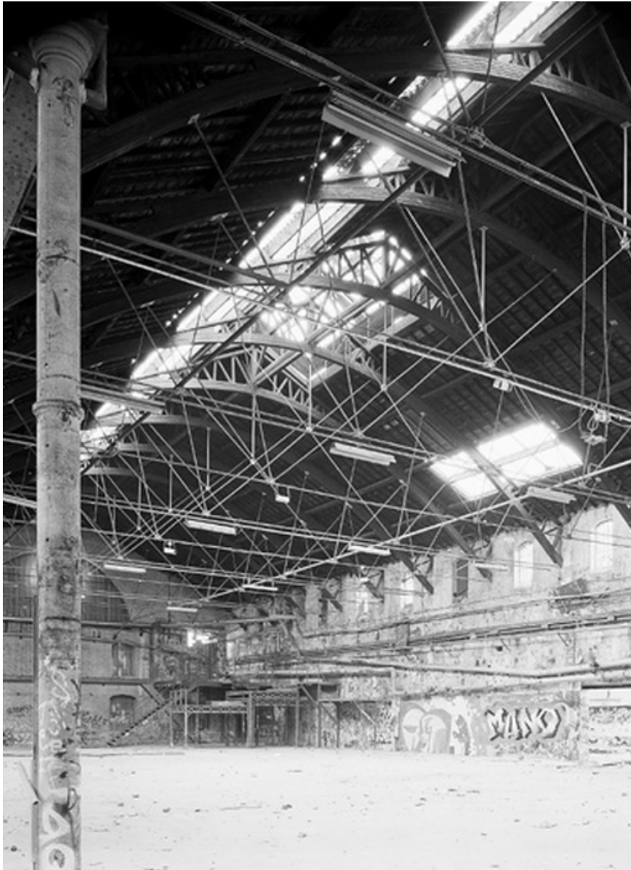
Vue intérieure, détail charpente
