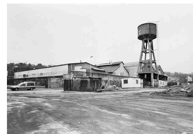
Vue sud de la rue des Docks Phot. Martial Couderette IVR82_20016900523P
