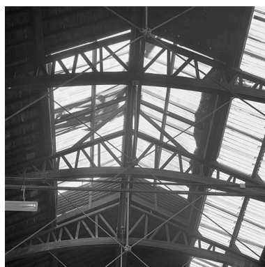
Détail charpente et soupirail Phot. Jean-Marie Refflé IVR82_20016903301X
