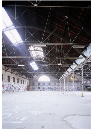
Vue intérieure ouest de la double halle couverte Phot. Martial Couderette IVR82_20006900343PA
