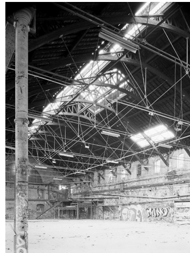
Vue intérieure, détail charpente Phot. Martial Couderette IVR82_20006900346P
