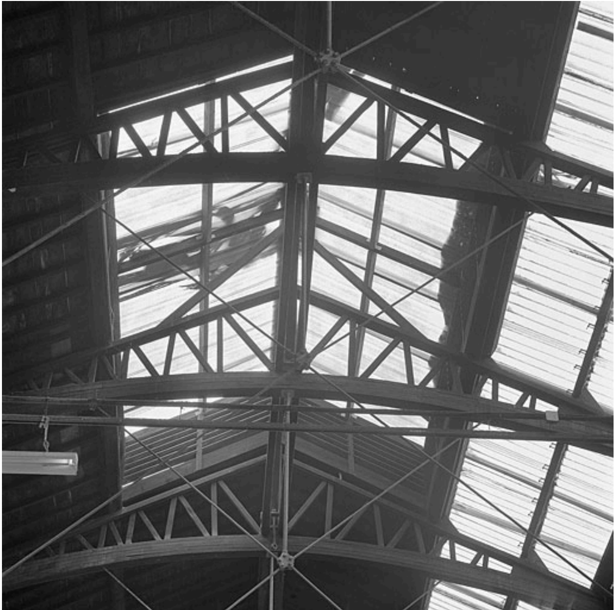
Détail charpente et soupirail
