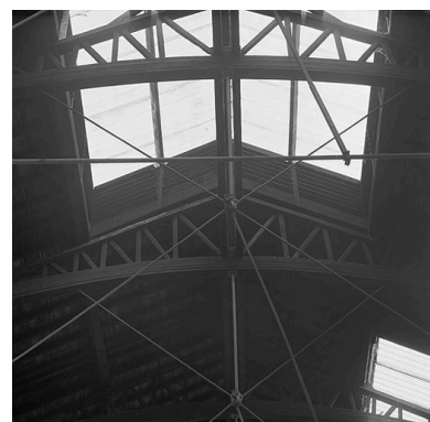
Détail charpente. Phot. Jean-Marie Refflé IVR82_20016903302X
