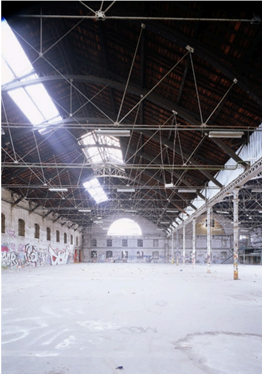
Vue intérieure ouest de la double halle couverte
