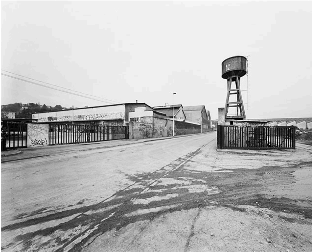
Vue d'ensemble de la rue des Docks : à gauche les chais Beaucairois
