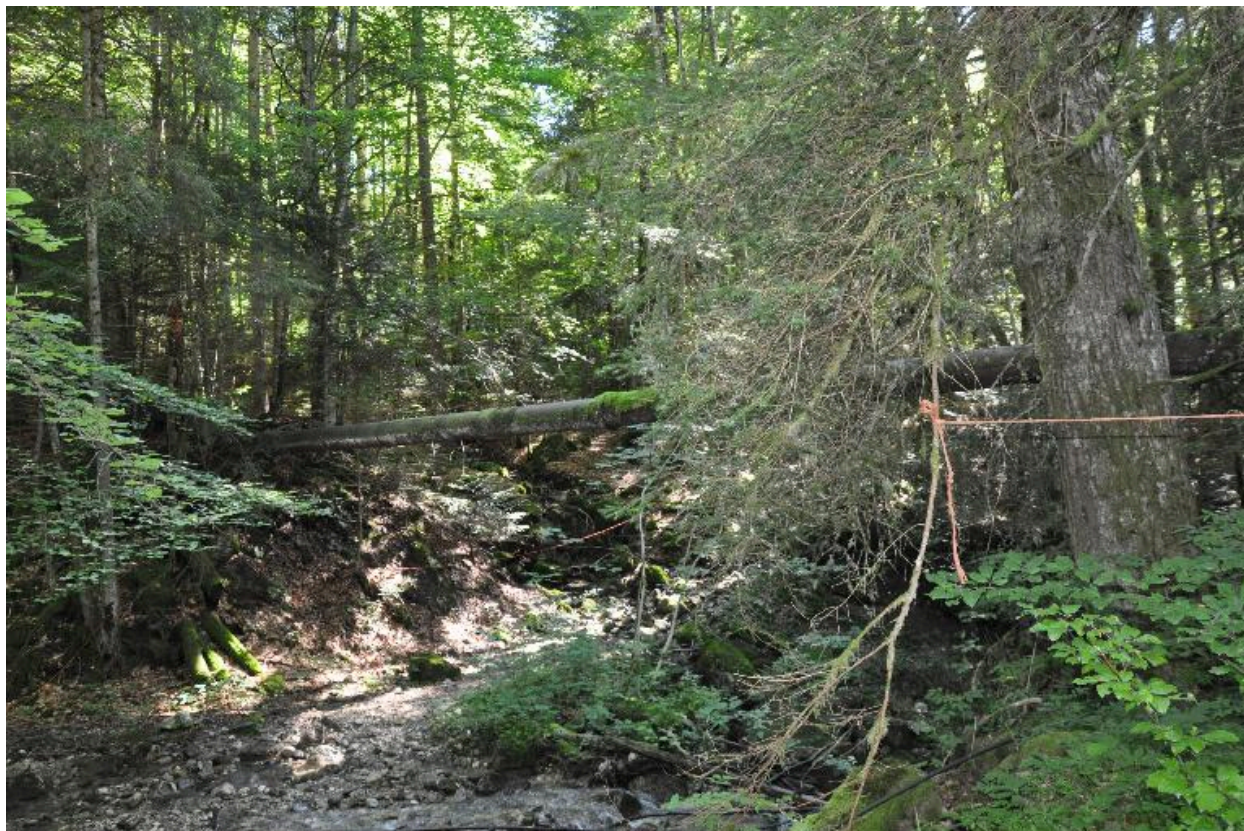
La conduite forcée franchissant le cours d'eau.
