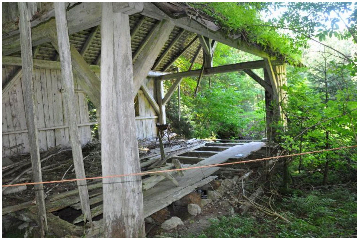
Vue générale de la scierie.
