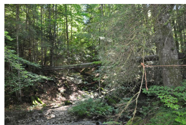
La conduite forcée franchissant le cours d'eau. Phot. Clara Bérelle IVR82_20137301866NUCA
