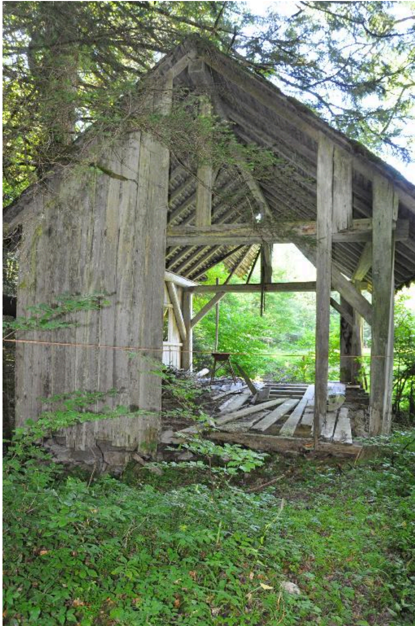
Vue du pignon ouest de la scierie.
