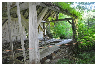
Vue générale de la scierie. Phot. Clara Bérelle IVR82_20137301863NUCA
