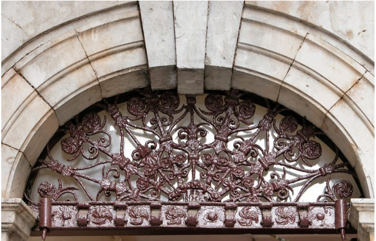
Elévation antérieure : détail de l'imposte
