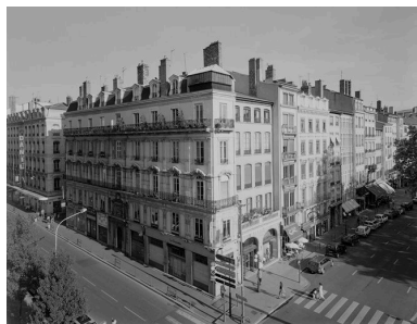
Vue de situation sur le quai Saint-Antoine (septième immeuble à partir de la gauche) Phot. Eric Dessert IVR82_20056901812V
