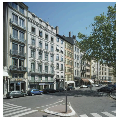
Vue de situation de l'élévation donnant sur le quai Saint- Antoine : il s'agit du cinquième immeuble à partir de la gauche Phot. Eric Dessert IVR82_20046905063NUCA
