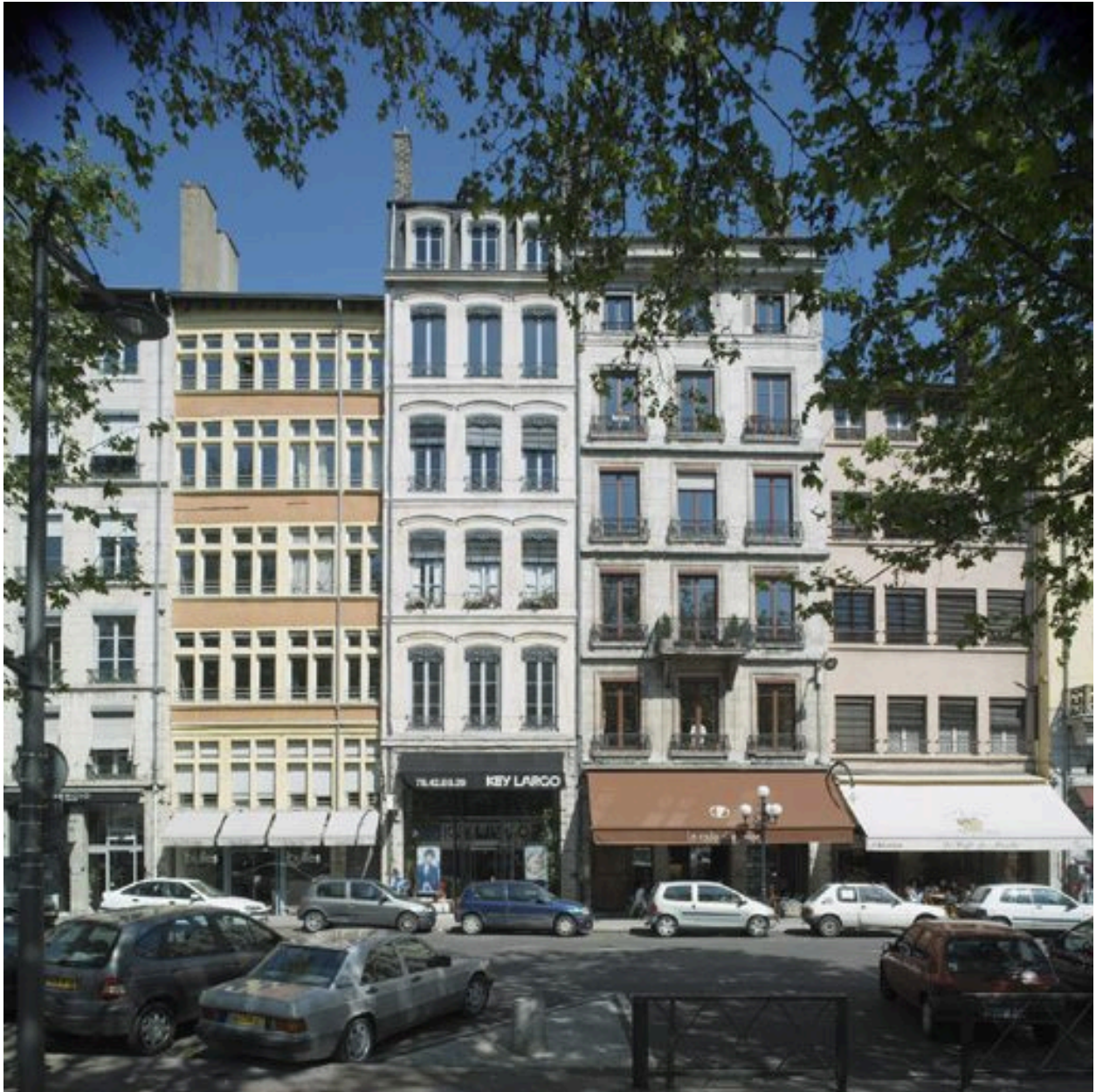
Vue de situation de l'élévation donnant sur le quai Saint-Antoine : il s'agit du deuxième immeuble à partir de la gauche
