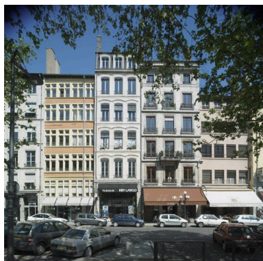
Vue de situation de l'élévation donnant sur le quai Saint- Antoine : il s'agit du deuxième immeuble à partir de la gauche Phot. Eric Dessert IVR82_20046905065NUCA
