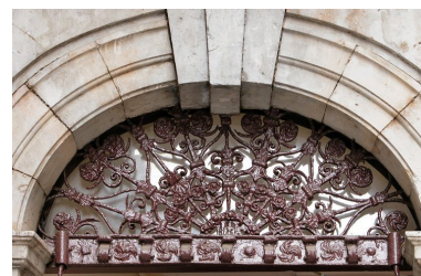
Elévation antérieure : détail de l'imposte Phot. Alexandre Rémond IVR82_20046905048NUCA
