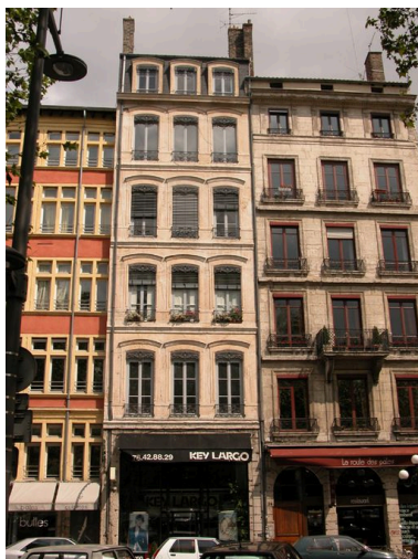
Elévation sur le quai Saint-Antoine Phot. David Chevallier IVR82_20046905092NUCA
