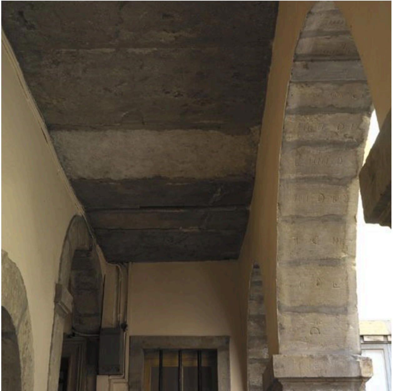
Vue de situation des marques de tâcheron et des marques de pose gravées dans une arcade de la cage d'escalier, troisième étage carré
