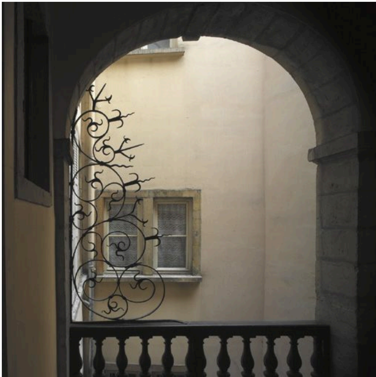
Escalier : grille de défense dite artichaut, deuxième étage carré
