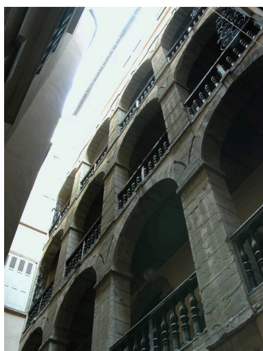
Cour : vue générale de la cage d'escalier
