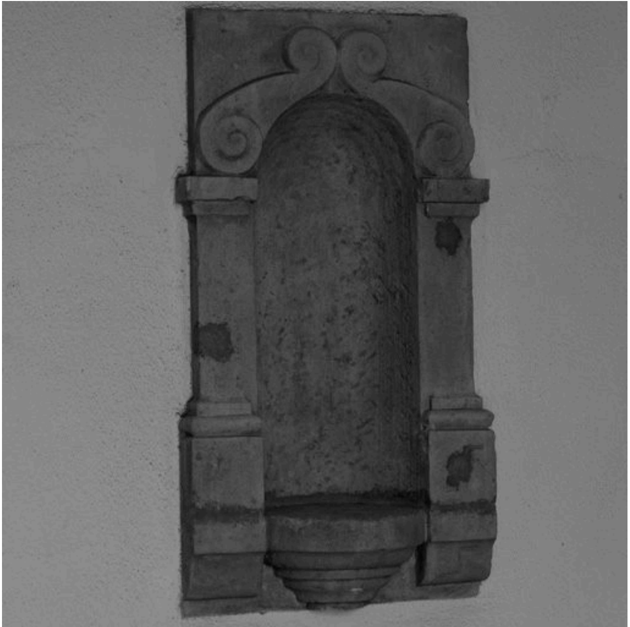
Escalier : niche d'éclairage
