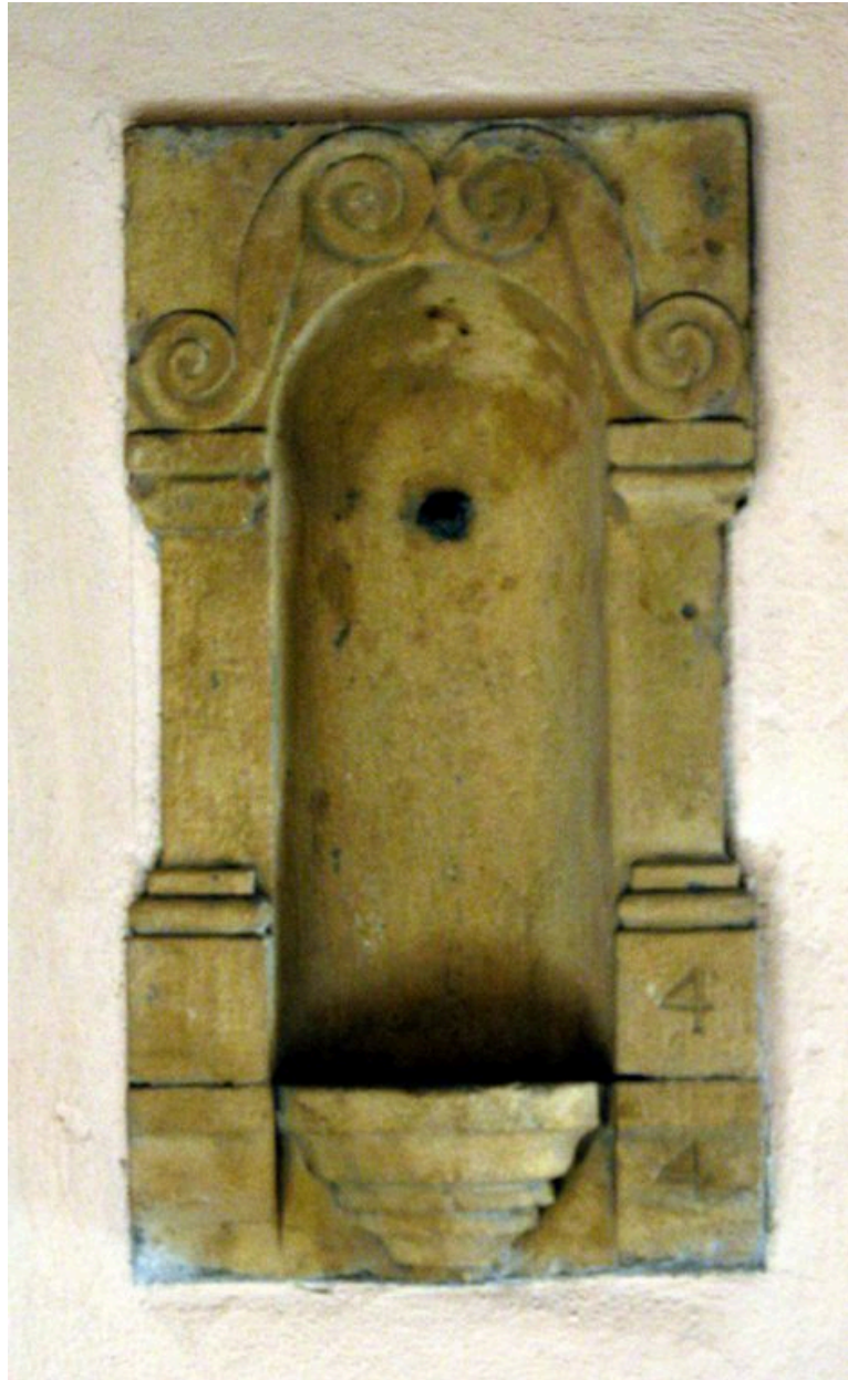
Cour : niche à lumière située à l'entrée de l'allée
