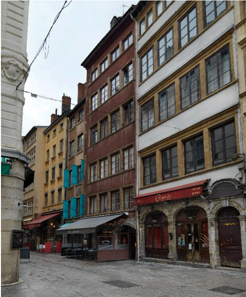
Vue de situation sur la rue Mercière depuis la rue Tupin (premier immeuble à partir de la droite)
