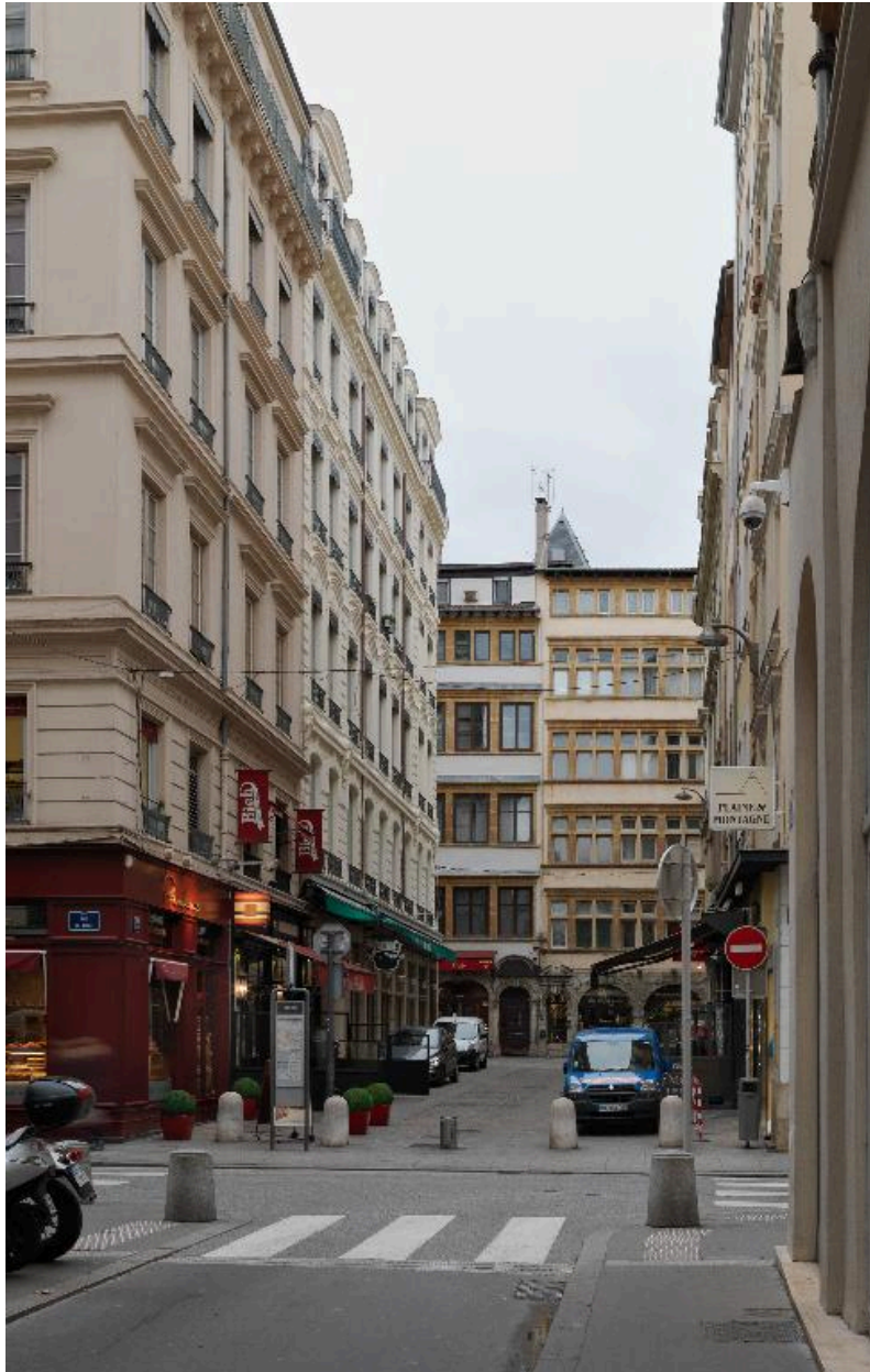
Vue de situation depuis la rue Tupin. L'étage de guette, couvert d'un toit en pavillon, est visible
