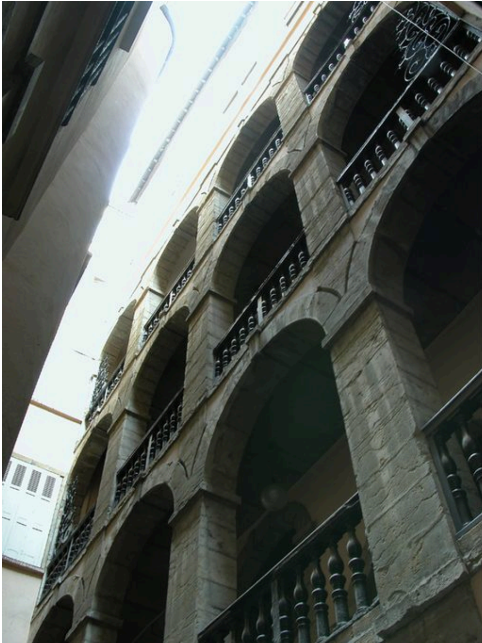
Cour : vue générale de la cage d'escalier
