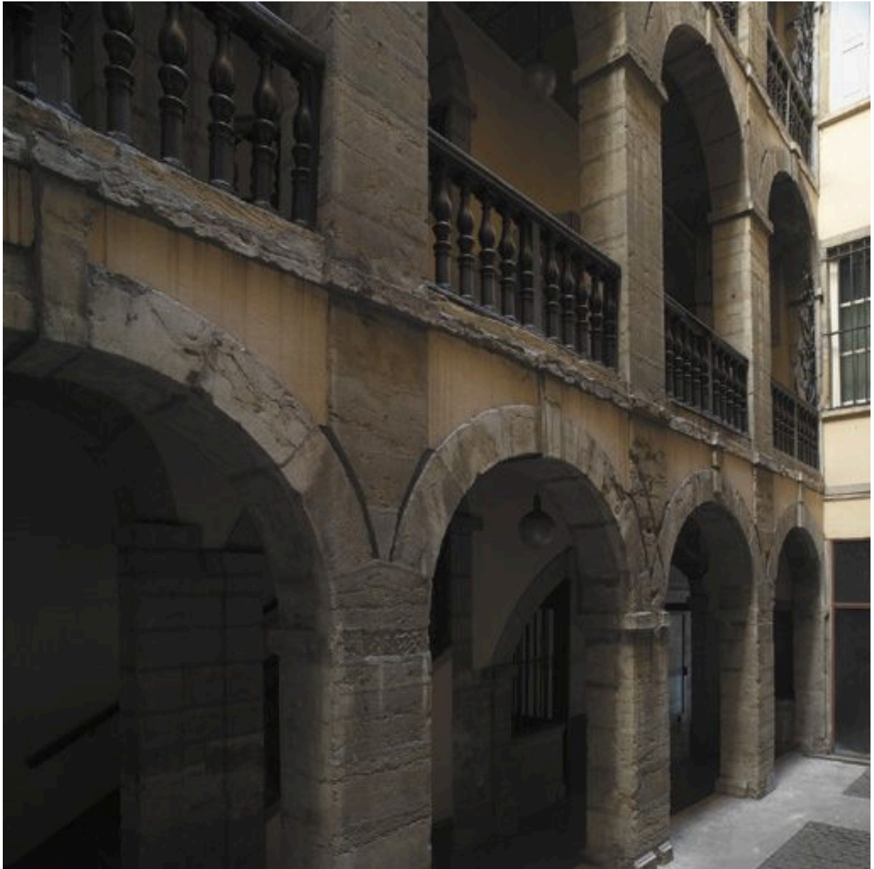
Cour : vue partielle de la cage d'escalier
