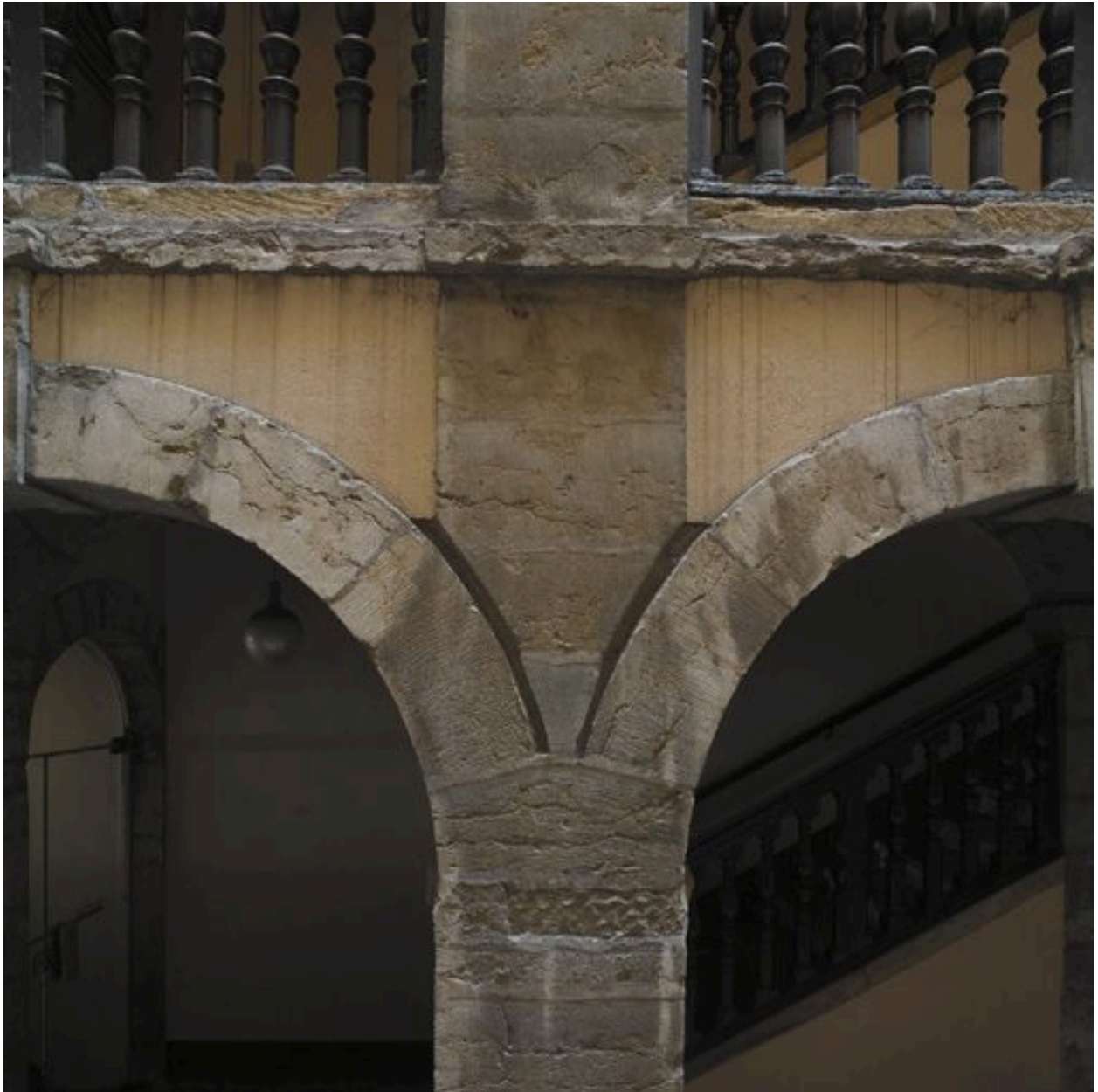
Cour : intersection de deux arcades de la cage d'escalier
