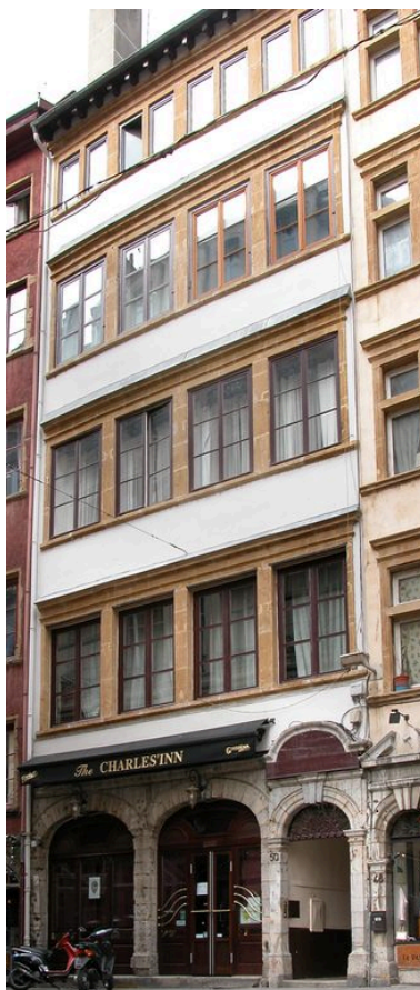
Elévation antérieure rue Mercière Phot. Alexandre Rémond
