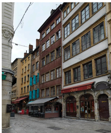
Vue de situation sur la rue Mercière depuis la rue Tupin (premier immeuble à partir de la droite) Phot. Thierry Leroy IVR82_20156902017NUCAQ
