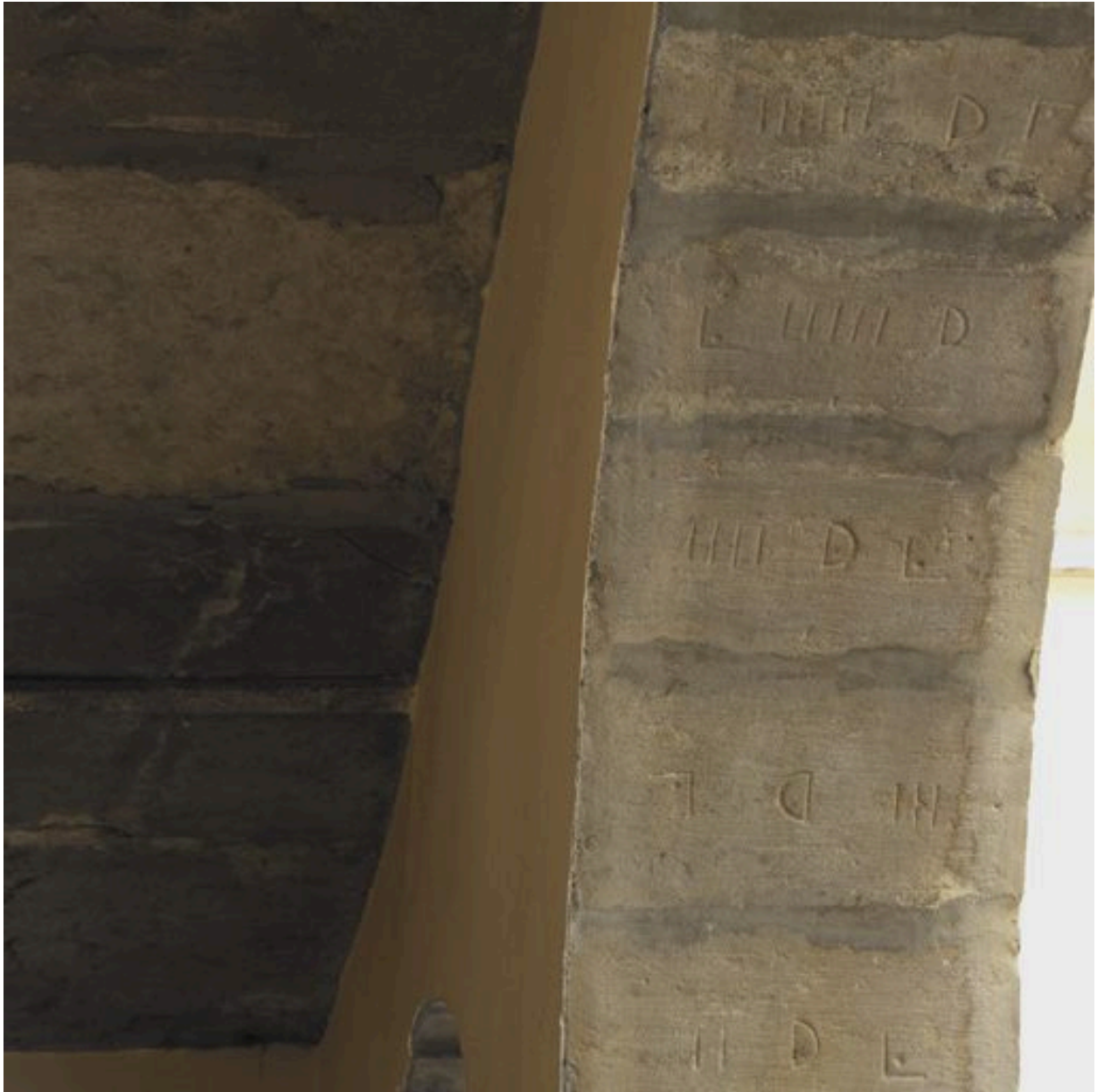
Détail des marques de tâcheron et des marques de pose gravées dans une arcade de la cage d'escalier, troisième étage carré
