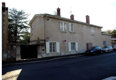
Vue de l'élévation postérieure, côté rue Phot. Véronique Belle IVR82_20066900784NUCA
