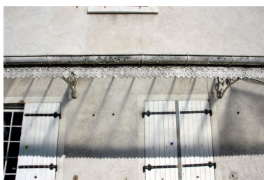
Elévation antérieure : détail de la marquise Phot. Catherine Guégan IVR82_20076900008NUCA
