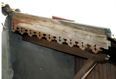
Resserre : détail du lambrequin Phot. Catherine Guégan IVR82_20076900010NUCA
