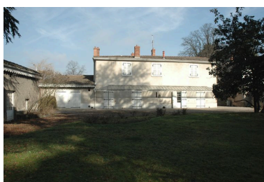
Vue de l'élévation antérieure, côté jardin Phot. Catherine Guégan IVR82_20076900001NUCA
