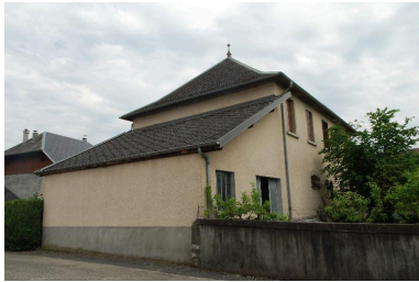
Vue de trois-quarts arrière, depuis le nord-ouest. Phot. Thierry Monnet IVR84_20187301379NUCA
