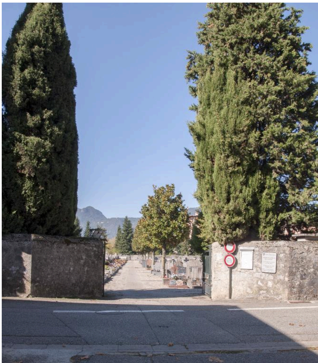
Entrée secondaire donnant sur la section 5
