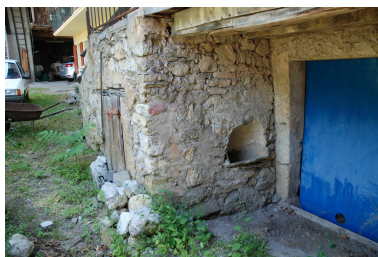
Détail de la loge à porc. Phot. Thierry Monnet IVR84_20247300958NUCA
