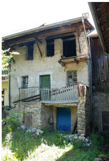
Vue d'ensemble. Phot. Thierry Monnet IVR84_20247300957NUCA
