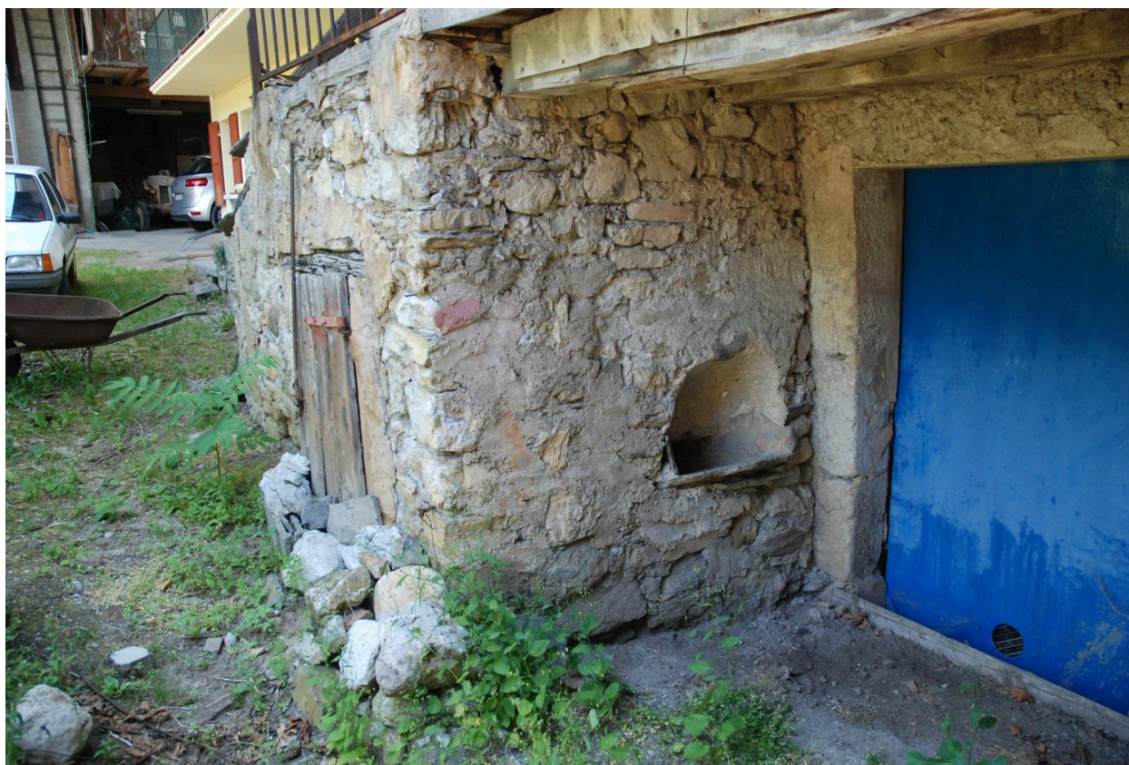
Détail de la loge à porc.
