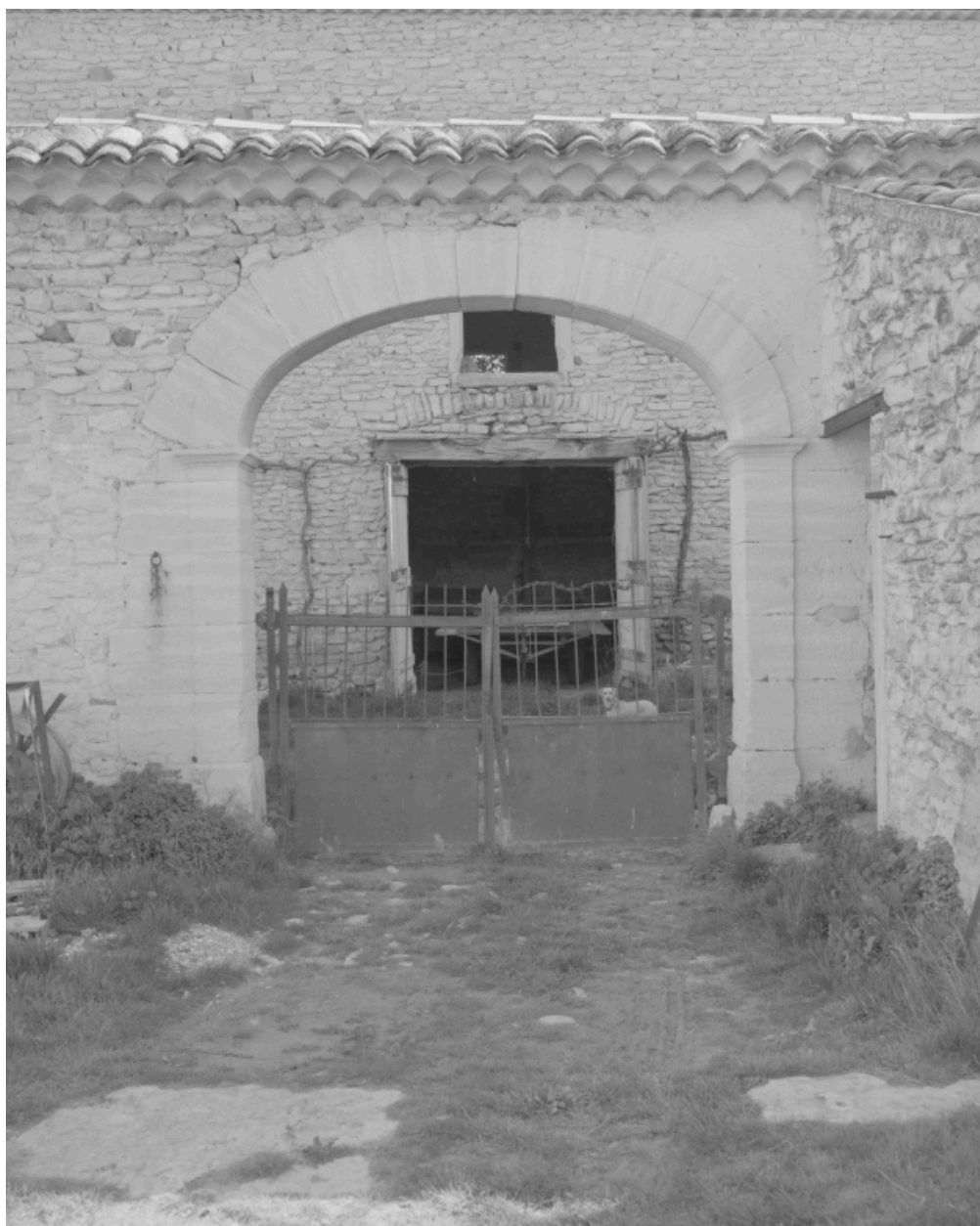
Les Condamines (C1 59). Portail d'entrée sur cour.
