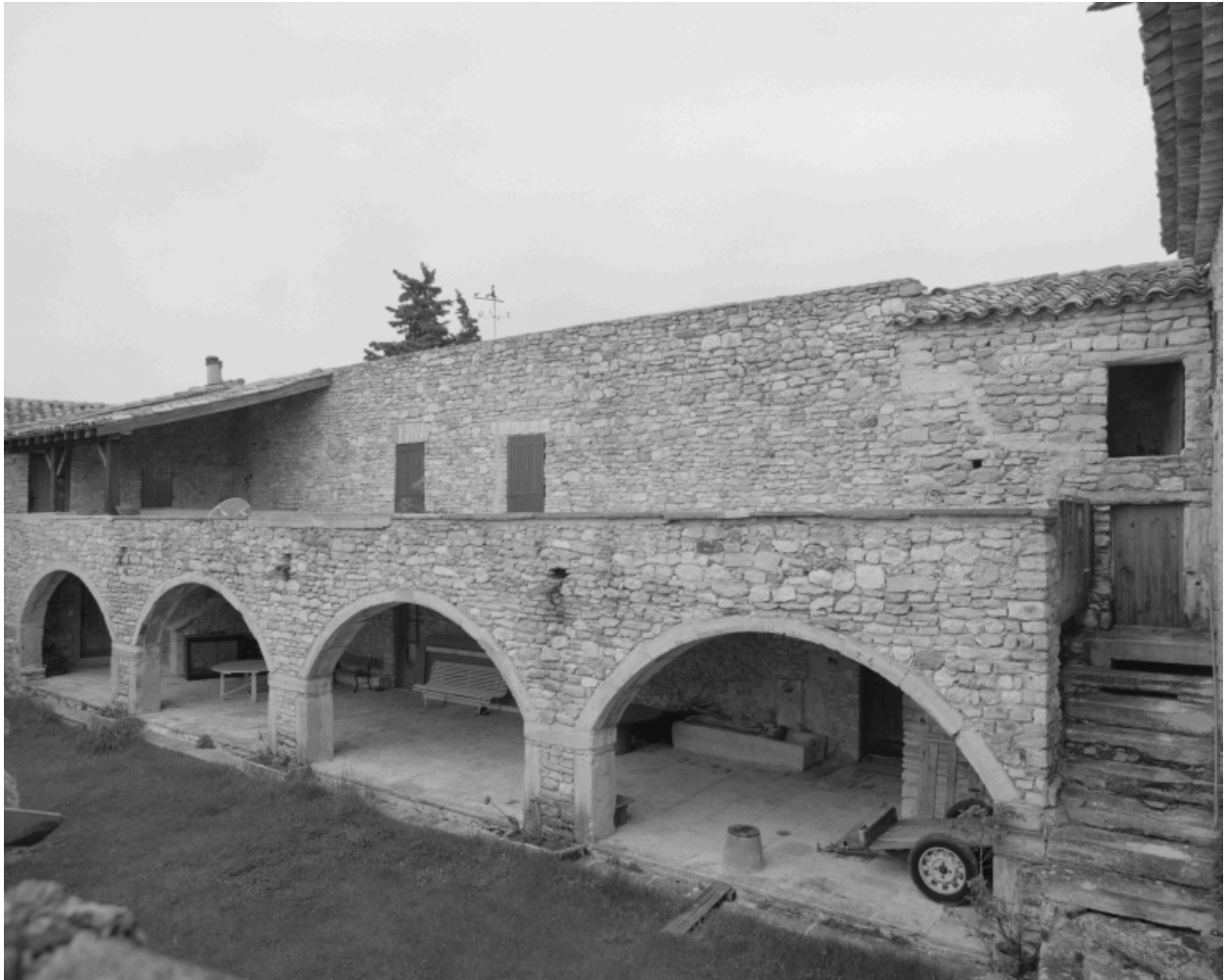
Quartier Rousselle (A3 530). Elévation sud, à galerie accessible par escalier extérieur.
