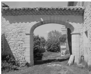
Les Condamines (C1 59). Portail d'entrée sur cour. Phot. Alain Franchella IVR82_20002600339X
