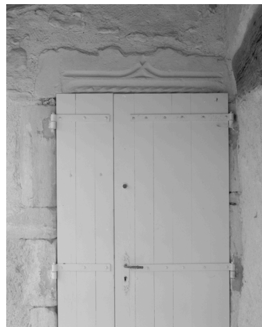
Chèvre, chemin de Taulignan au Poët-Laval. Porte d'entrée sur la galerie : détail du linteau orné d'une accolade et de moulures. Phot. Alain Franchella IVR82_20002600386X
