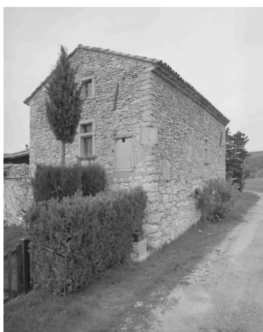
Quartier Rousselle (A3 530). Vue de trois quarts de l'ancien logis, devenu dépendance agricole. Phot. Alain Franchella IVR82_20002600394X
