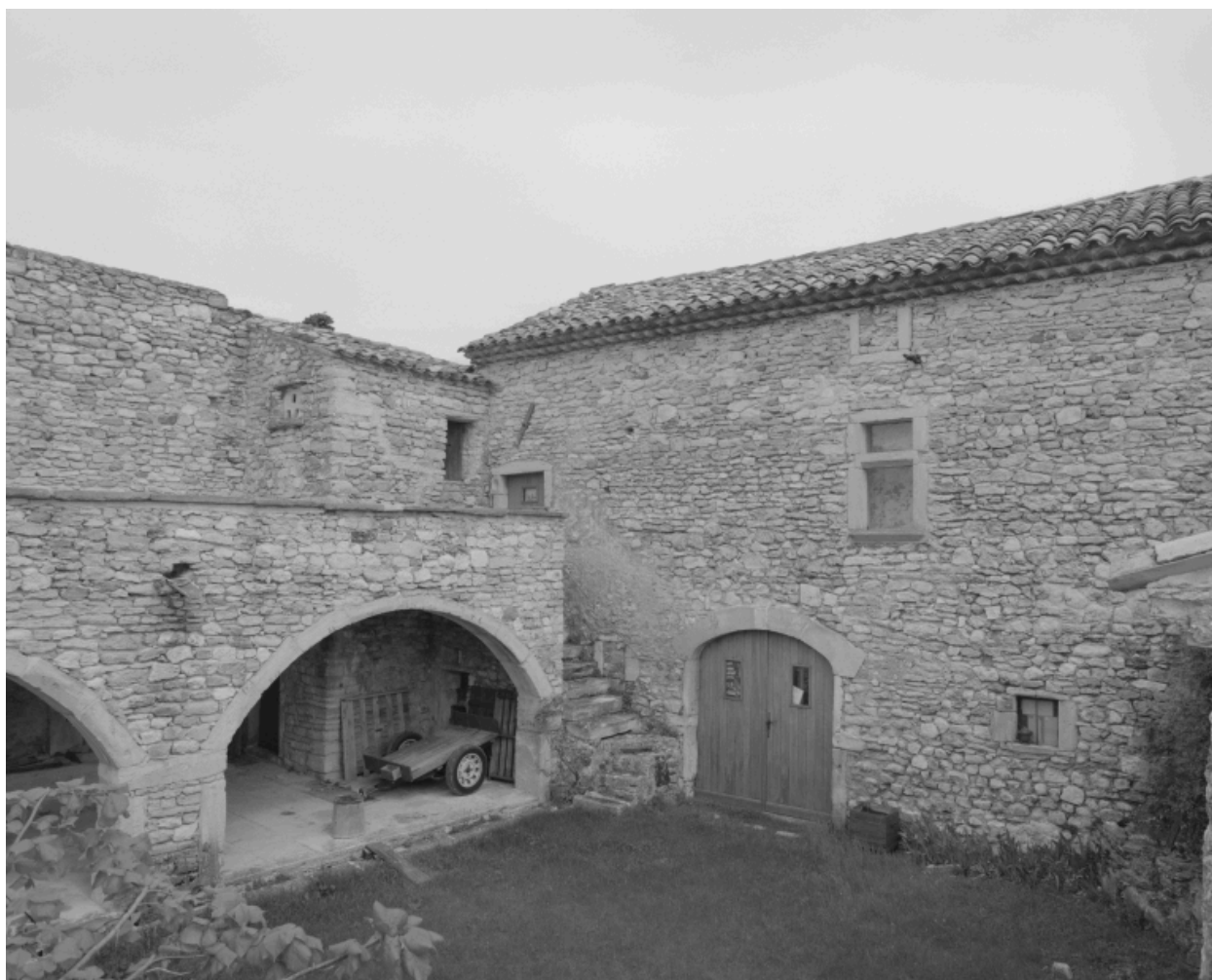
Quartier Rousselle (A3 530). Vue partielle des dépendances agricoles sur cour : à droite l'ancien logis.
