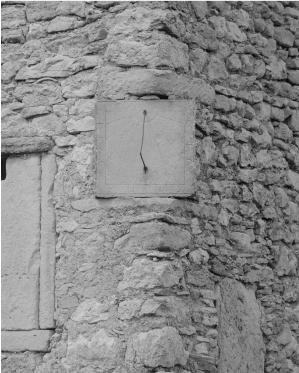
Quartier Rousselle (A3 530). Cadran solaire daté de 1688, placé sur l'angle de l'ancien logis.
