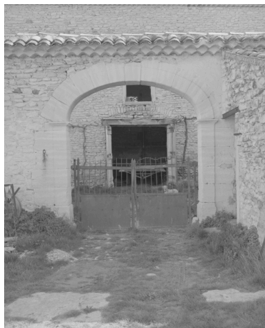
Les Condamines (C1 59). Portail d'entrée sur cour. Phot. Alain Franchella IVR82_20002600375X
