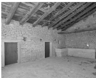
La Garrigue. Intérieur du hangar. Phot. Alain Franchella, Phot. Martial Couderette IVR82_20002600252X
