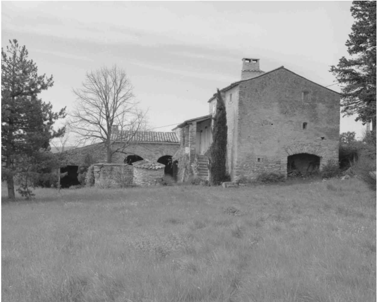
Chèvre, chemin de Taulignan au Poët-Laval. Vue générale de la ferme.
