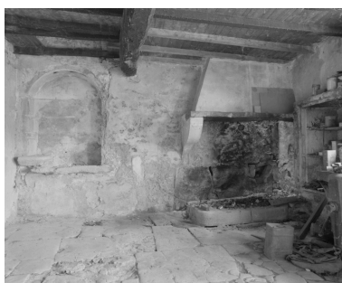
Basses Condamines, chemin de Taulignan aux carrières. Vue intérieure de l'ancien logis, au sol dallé en pierre : évier, cheminée, placard mural. Phot. Alain Franchella, Phot. Martial Couderette IVR82_20002600265X
