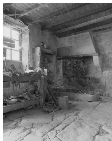
Basses Condamines, chemin de Taulignan aux carrières. Détail de l'ancien logis : cheminée, placard mural et dalles de pierre. Phot. Alain Franchella, Phot. Martial Couderette IVR82_20002600266X
