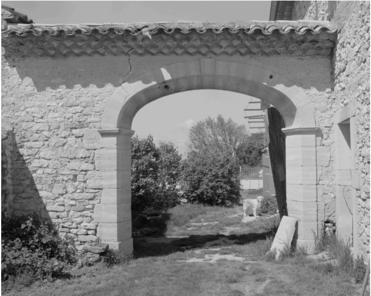
Les Condamines (C1 59). Portail d'entrée sur cour.
