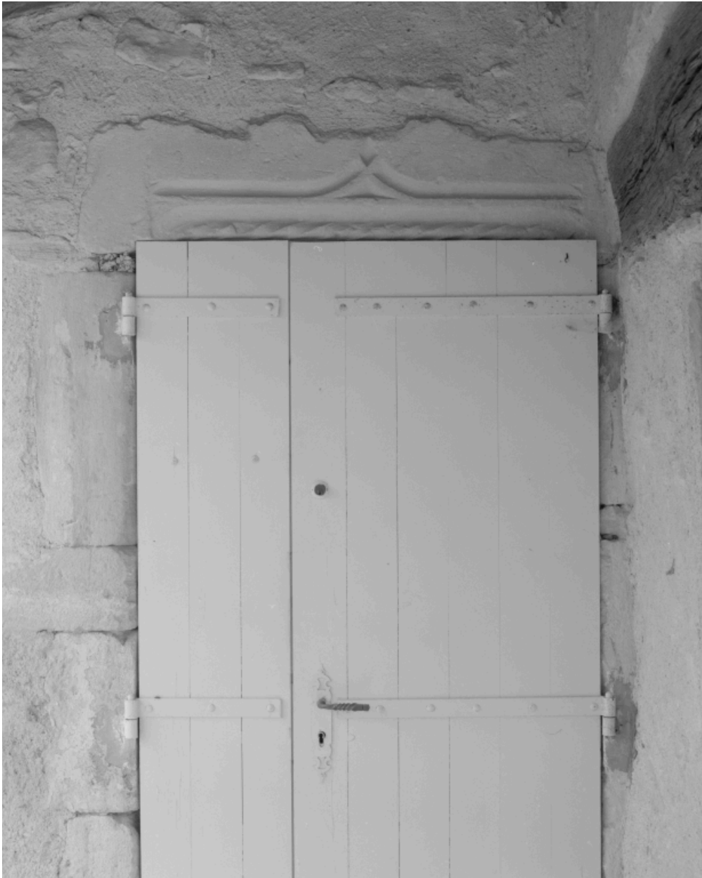
Chèvre, chemin de Taulignan au Poët-Laval. Porte d'entrée sur la galerie : détail du linteau orné d'une accolade et de moulures.
