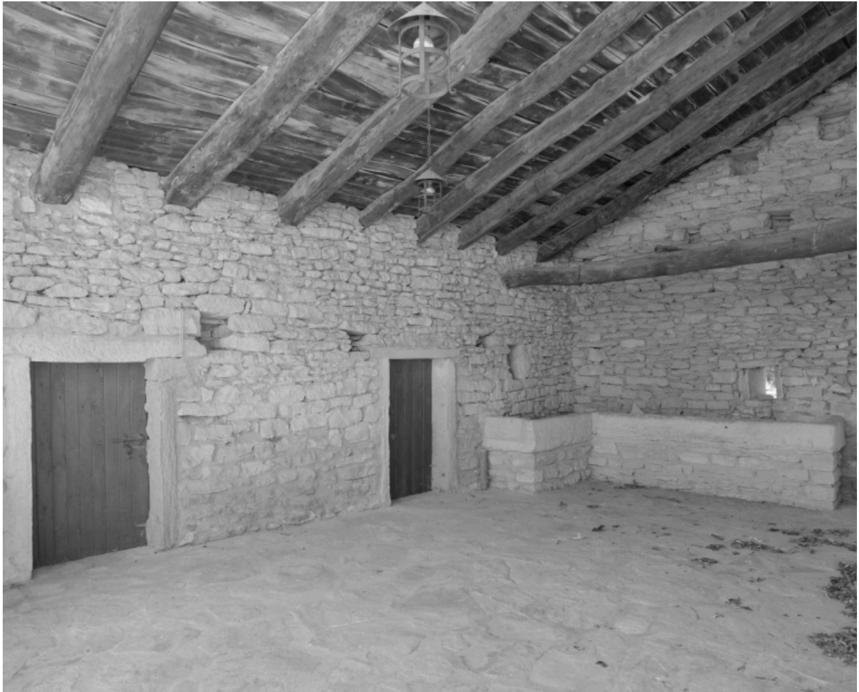
La Garrigue. Intérieur du hangar.
