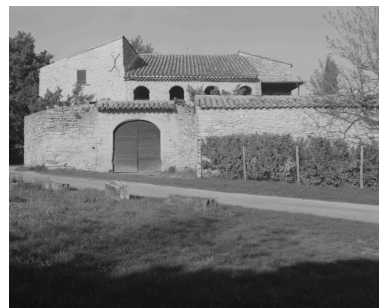
Serret, chemin de l'Alençonne. Vue d'ensemble de l'Alençonne, ancienne ferme et à l'origine léproserie. Phot. Alain Franchella IVR82_20002600351X
