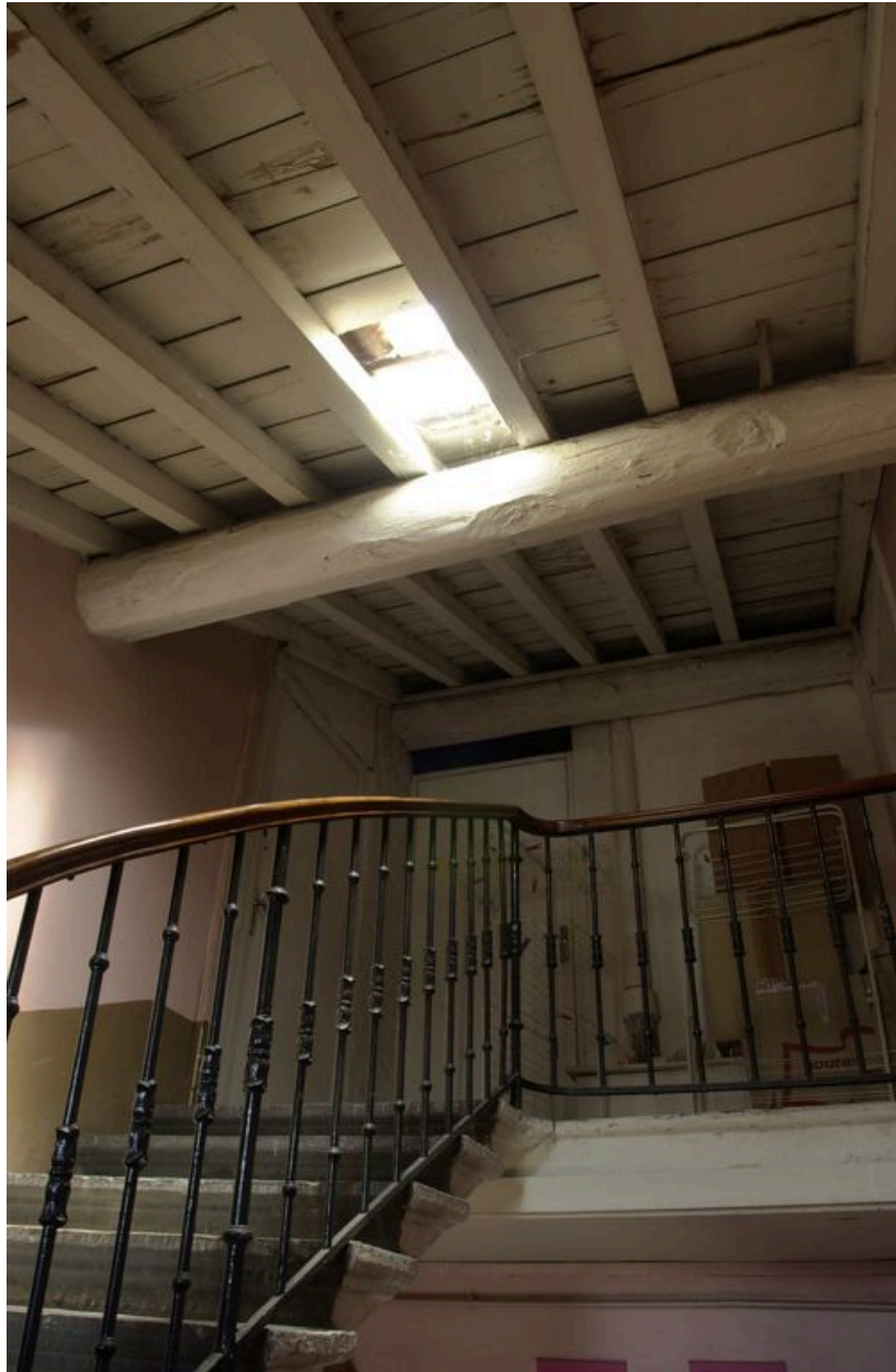
Dernier étage de la cage d'escalier
