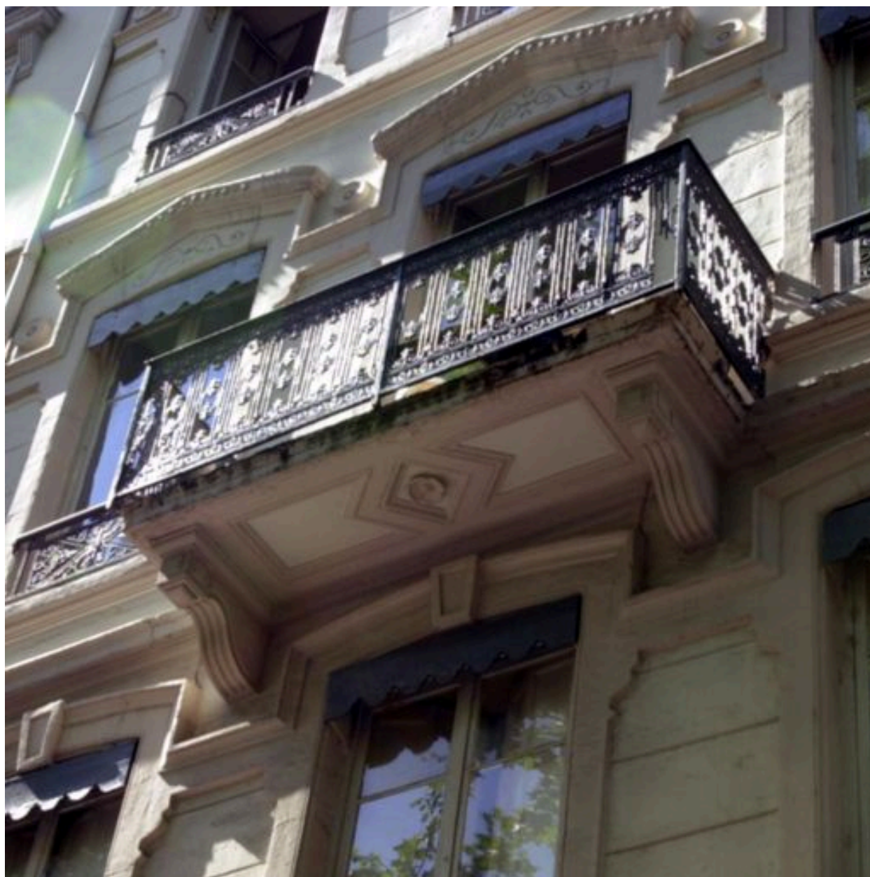
Détail du balcon
