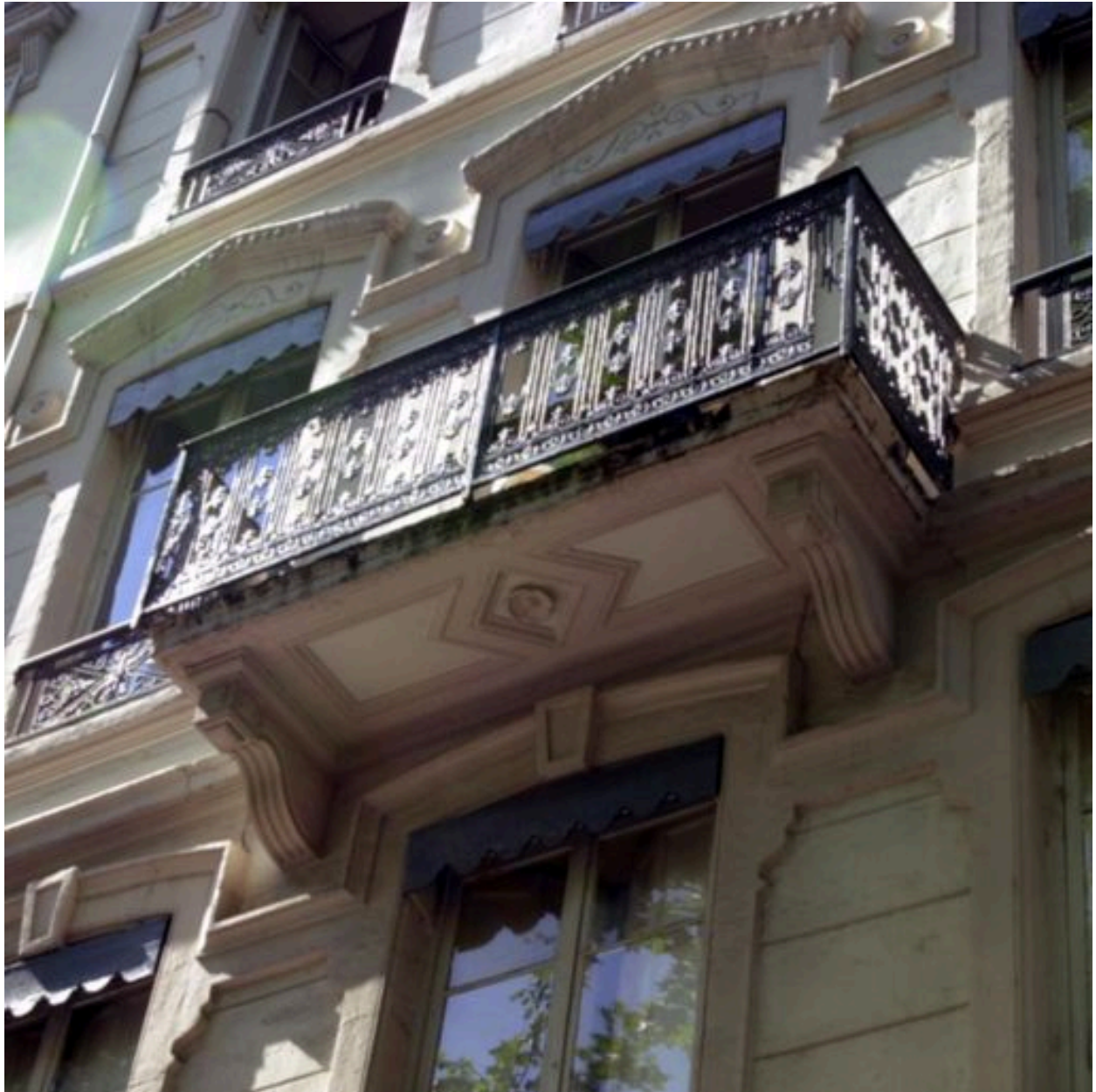
Détail du balcon
