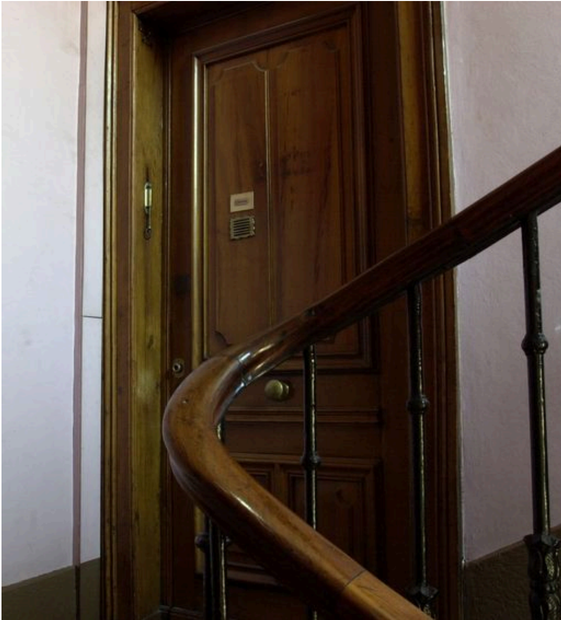
Vue d'une porte palière
