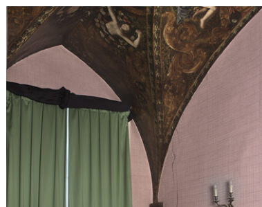
Vue partielle de la voûte d'arêtes. Phot. Didier Gourbin IVR82_20064201099NUCA
