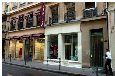
Le rez-de-chaussée Phot. David Chevallier IVR82_20046905254NUCA
