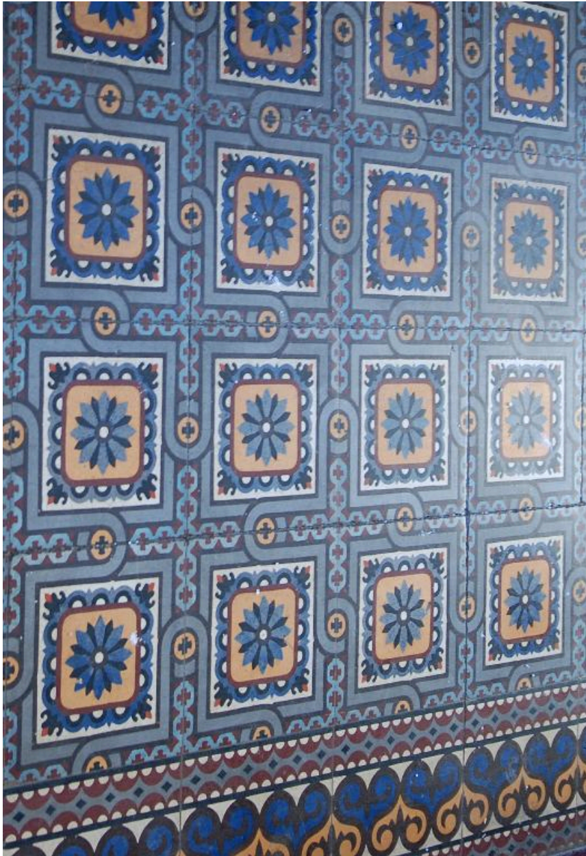
Vue intérieure : détail du pavement de l'allée
