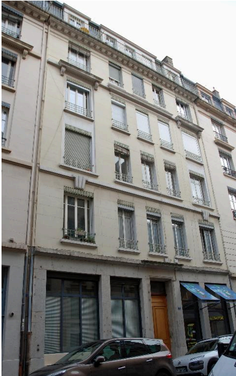
Vue générale de l'élévation sur rue
