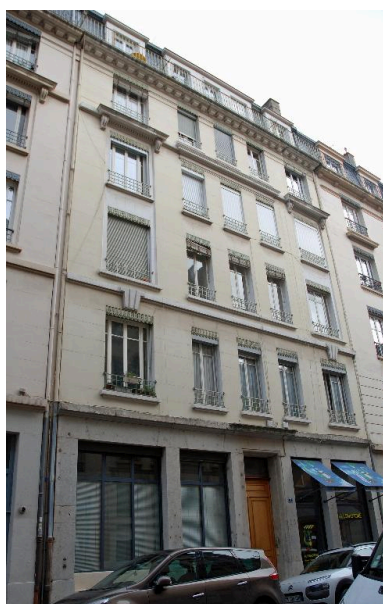
Vue générale de l'élévation sur rue Phot. Magali Delavenne IVR82_20146902994NUCA
