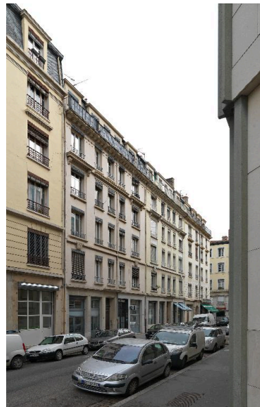
Vue d'ensemble des 5-7 rue de Bonald, immeubles jumelés Phot. Eric Dessert IVR84_20166901366NUCA
