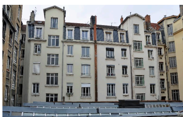
Elévations sur cour des 5-7, rue de Bonald (immeubles en miroir) Phot. Magali Delavenne IVR82_20146902925NUCA
