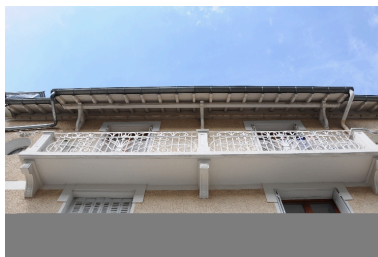
Balcon au 2e étage et décrochement du toit Phot. François Fouger IVR82_20127300018NUCA
