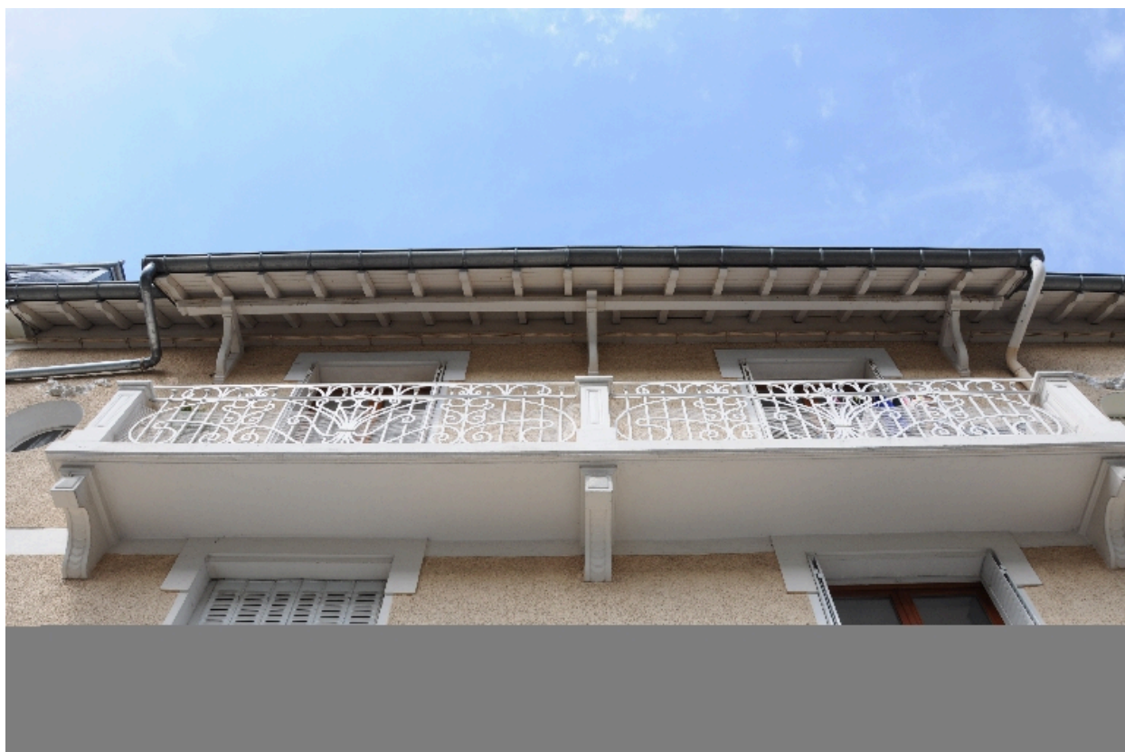
Balcon au 2e étage et décrochement du toit
