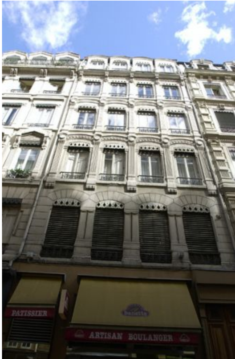
Façade, vue générale par-dessous
