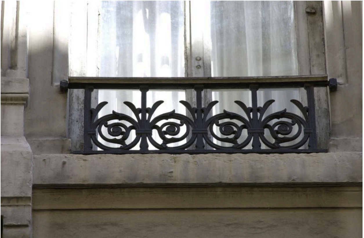
Façade, 3e niveau, détail du garde-corps de la 3e fenêtre
