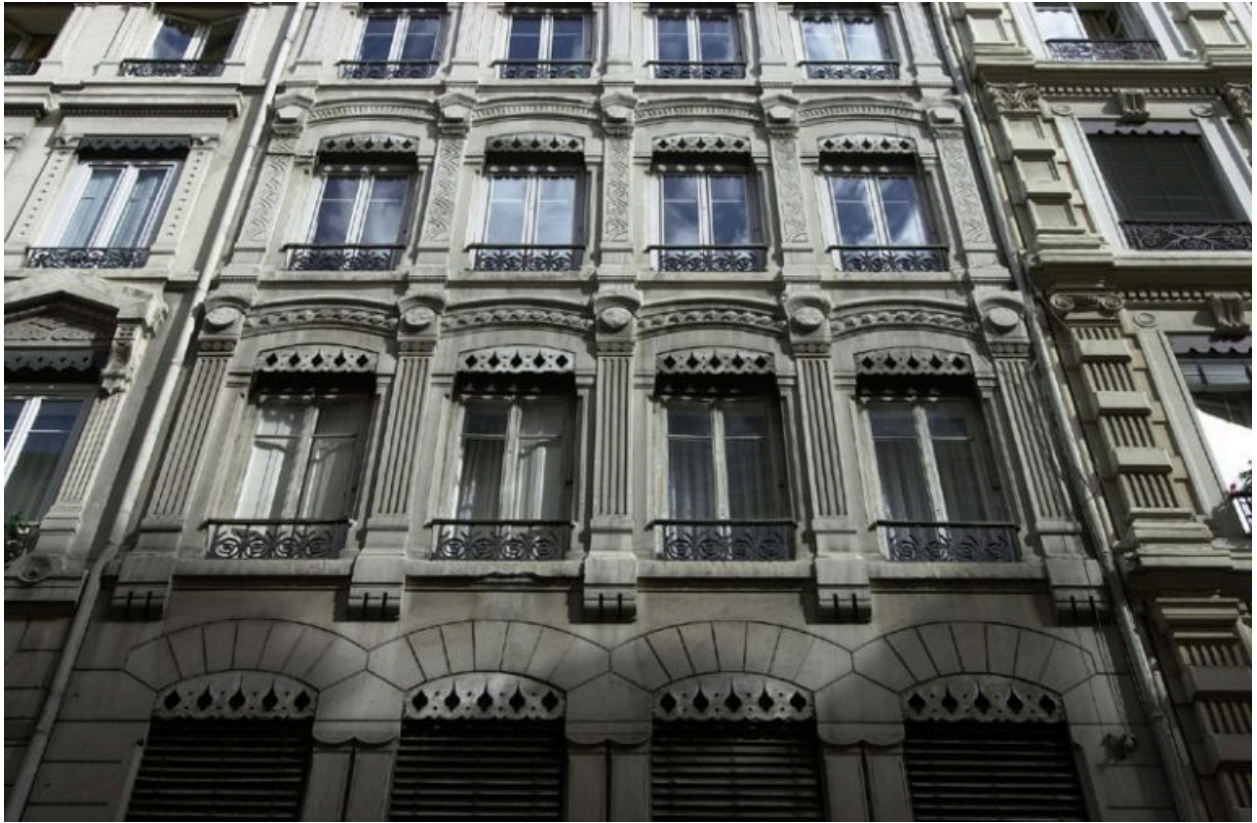
Façade, 3e et 4e niveaux
