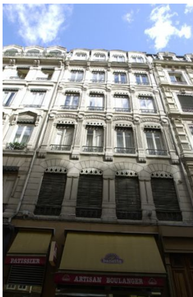
Façade, vue générale par-dessous Phot. Bernard Ducouret IVR82_20046900993NUCA
