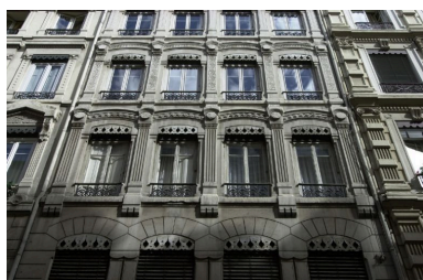
Façade, 3e et 4e niveaux Phot. Bernard Ducouret IVR82_20046900995NUCA
