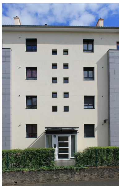
Riom, la cité HLM de la route de Marsat, détail de la façade nord-ouest du bâtiment A. Phot. Christophe Laurent IVR84_20216302667NUCA
