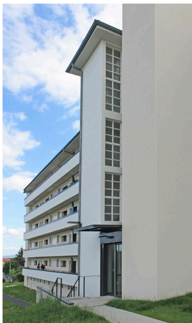
Riom, la cité HLM de la route de Marsat, partie droite (sud-est) du bâtiment E vue du nord. Phot. Christophe Laurent IVR84_20216302674NUCA
