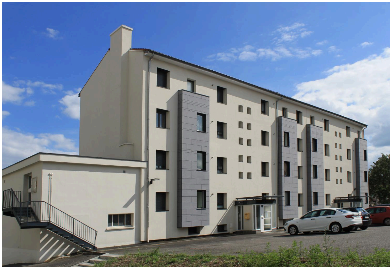
Riom, la cité HLM de la route de Marsat, bâtiment C vu du nord.
