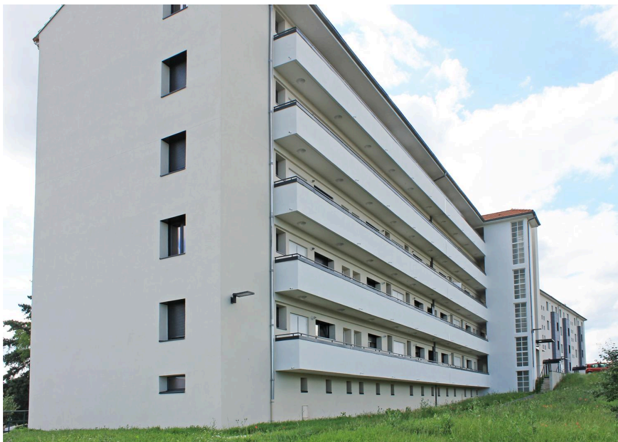
Riom, la cité HLM de la route de Marsat, partie droite (sud-est) du bâtiment E vue de l'est.
