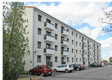
Riom, la cité HLM de la route de Marsat, bâtiment D vu du sud. Phot. Christophe Laurent IVR84_20216302672NUCA
