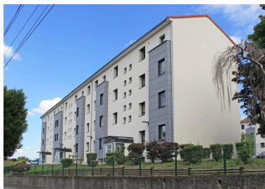
Riom, la cité HLM de la route de Marsat, bâtiment D vu du nord-ouest. Phot. Christophe Laurent IVR84_20216302671NUCA
