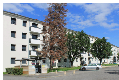
Riom, la cité HLM de la route de Marsat, façade sud-ouest du bâtiment E. Phot. Christophe Laurent IVR84_20216302678NUCA
