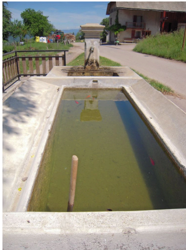
Vue du grand bassin. Phot. Clémence Serve IVR82_20117403502NUCA
