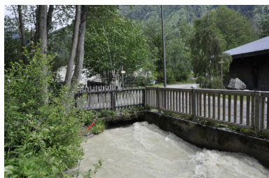
Vue de la face aval de la passerelle Phot. Samir Mahfoudi IVR84_20207401312NUCA
