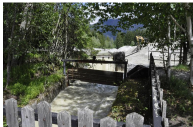
Amorce du canal de fuite du bassin de la gravière Phot. Samir Mahfoudi IVR84_20207401309NUCA
