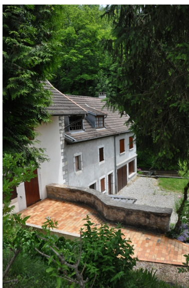
Vue générale, façade sud Phot. Yannick Milleret IVR82_20107300871NUCA
