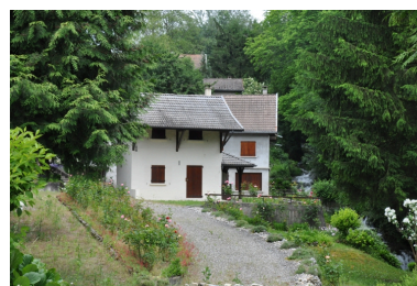
Vue du moulin depuis le chemin d'accès Phot. Yannick Milleret IVR82_20107300872NUCA
