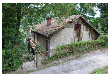
Vue de trois-quart depuis le sud-est Phot. Denys Harreau IVR82_20137300644NUCA
