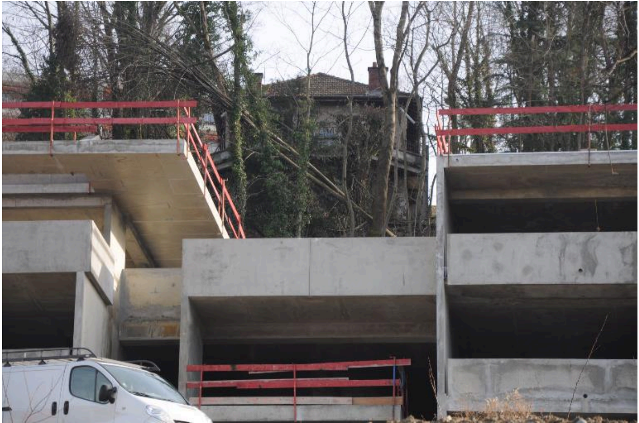
Vue depuis le boulevard des Anglais, à l'ouest
