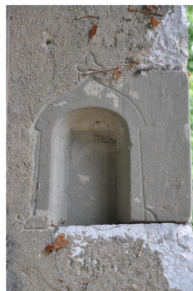
Niche sculptée dans un bloc de molasse de la chaîne d'angle sud-est Phot. Denys Harreau IVR82_20137300640NUCA
