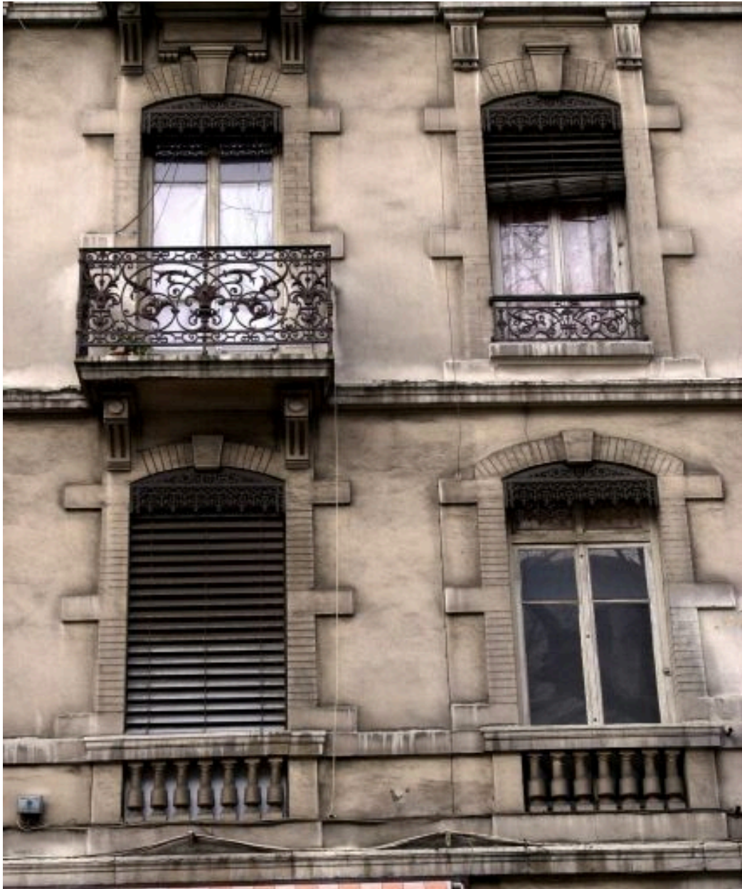
Détail de 2 travées de façade
