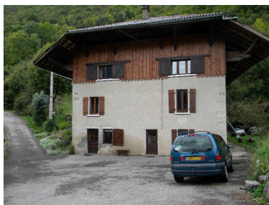
Vue du mur pignon d'une ancienne ferme (2008 C3 300) Phot. Jérôme Daviet IVR82_20137400979NUCA
