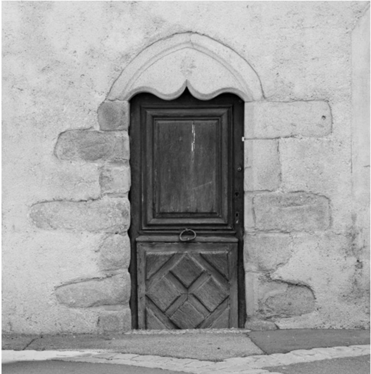
Porte piétonne avec linteau en accolade, 16 siècle.
