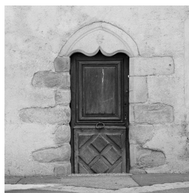
Porte piétonne avec linteau en accolade, 16 siècle. Phot. Didier Gourbin IVR82_20064200957X
