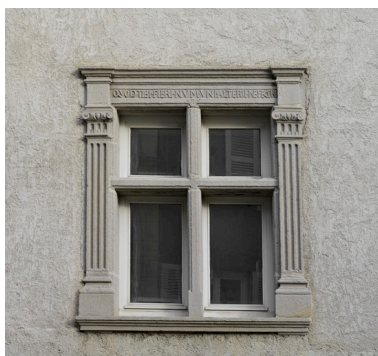
Fenêtre datée 1589. Phot. Eric Dessert IVR82_20084200056NUCA
