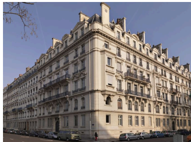
Vue générale de l'élevation sur le quai Claude Bernard. Phot. Didier Gourbin IVR82_20126902023NUCA
