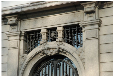
Détail de l'entrée située 2 place Ollier. Phot. Catherine Guillot IVR82_20126900826NUCA
