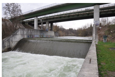
Vue générale du radier et du barrage du pont autoroutier de la sortie autoroutière d'Annecy Nord Phot. Samir Mahfoudi, Autr. Samir Mahfoudi IVR82_20107400013NUCA
