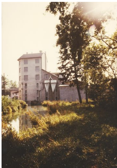
Vue des deux travées de l'élévation nord-est du bâtiment du nettoyage prise depuis la rive droite du canal d'aménée des Moulins de Brogny Phot. Samir Mahfoudi IVR82_20107400020NUCA
