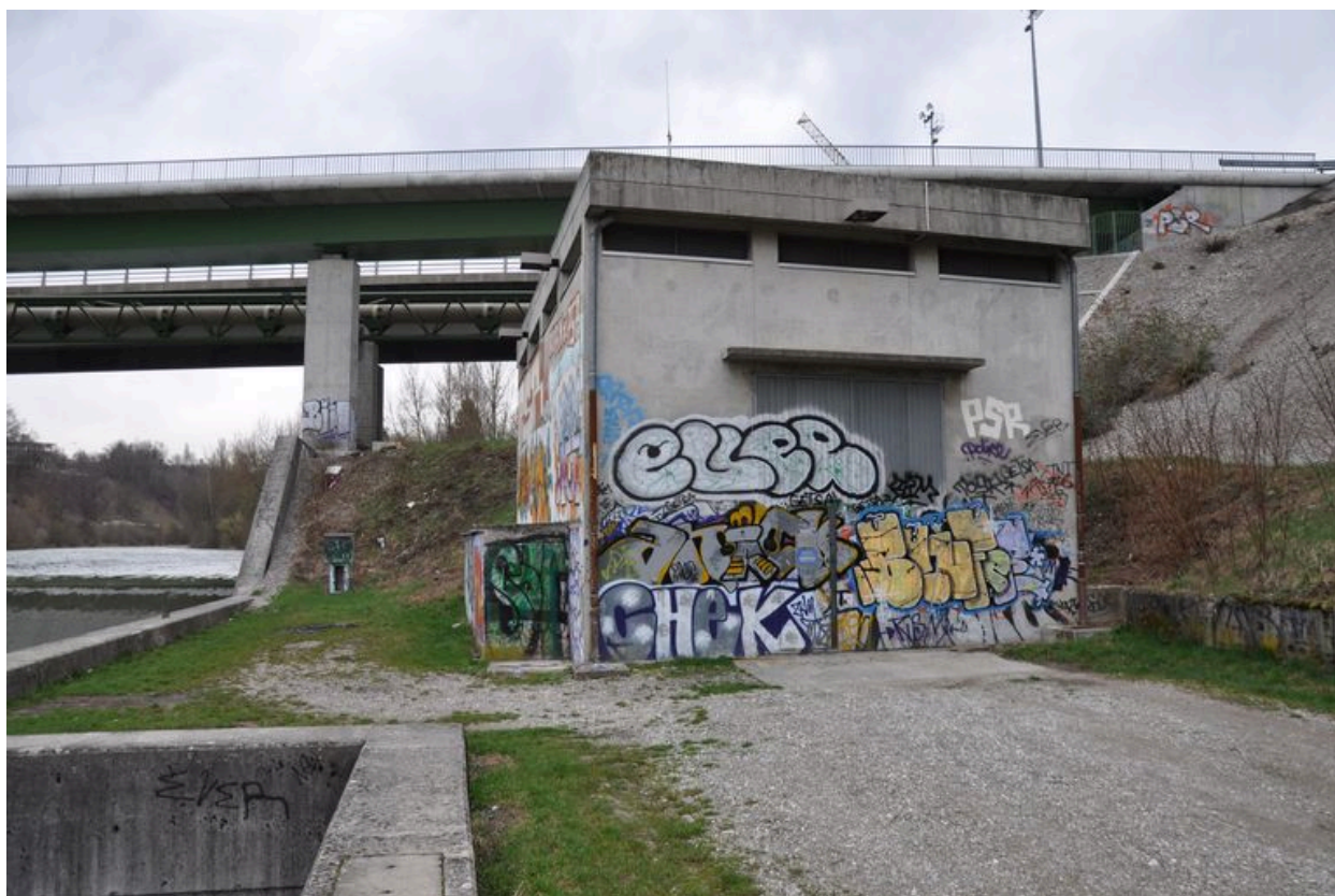
Bâtiment de la centrale d'appoint : vue de l'élévation sud-ouest
