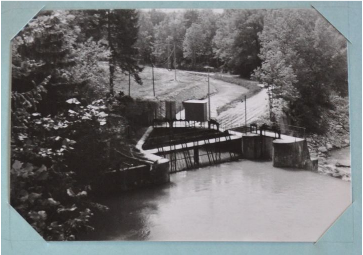
Prise d'eau de la Minoterie Cléchet avant les travaux de 1980 prise depuis le pont de Brogny
