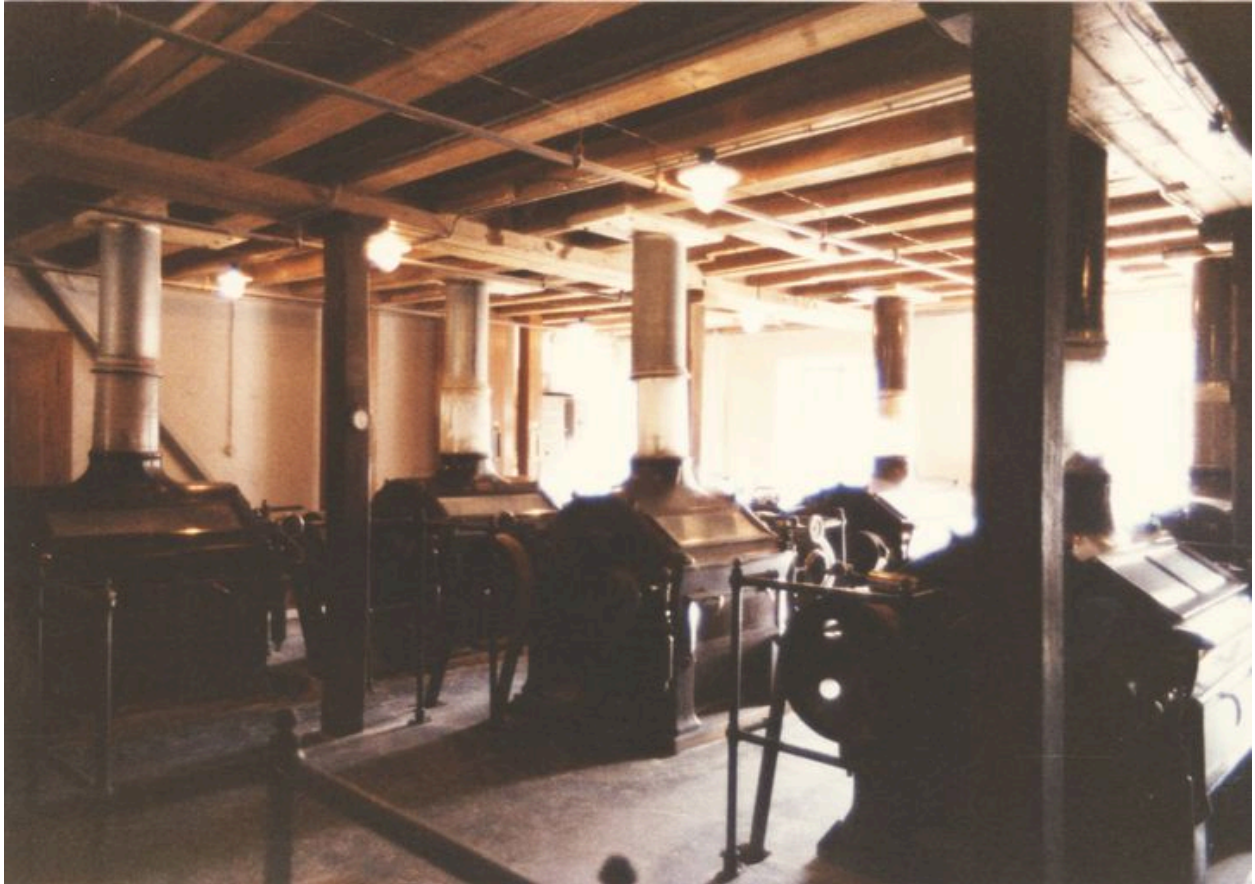
Détail des machines du bâtiment du moulin
