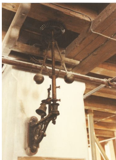
Détails de l'ancien système d'alarme du dispositif de régulation du bébit dans le canal d'amenée Phot. Samir Mahfoudi IVR82_20107400028NUCA
