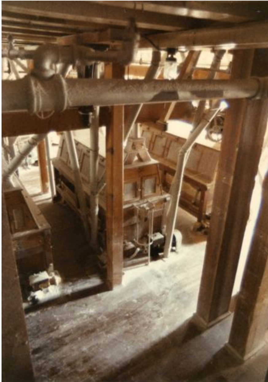
Vue intérieure des machines du bâtiment du moulin
