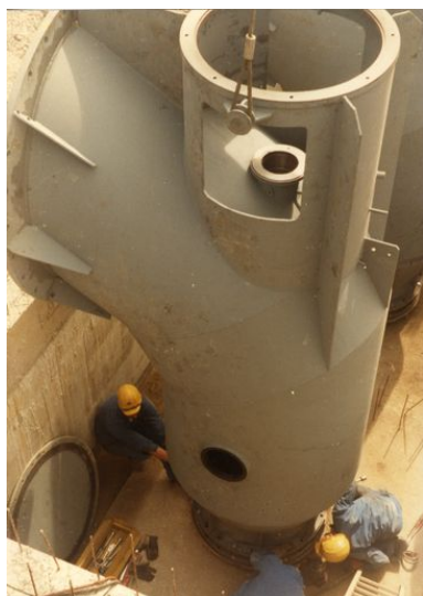
Détail d'une des deux turbines de la station d'appoint Phot. Samir Mahfoudi IVR82_20107400041NUCA
