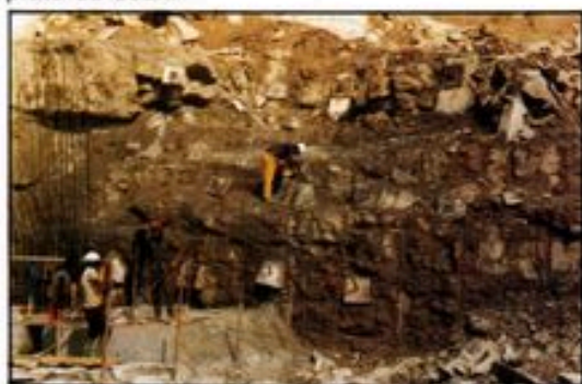
Juin 80 : tirants d'ancrage dans la molasse altérée et grillage de protection.
