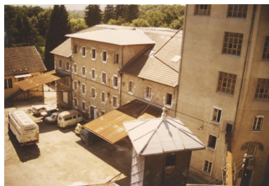
Vue d'ensemble des bâtiments de la Minoterie Cléchet prise depuis une baie du bâtiment des silos à grain en 1983 Phot. Samir Mahfoudi IVR82_20107400019NUCA
