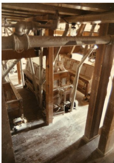
Vue intérieure des machines du bâtiment du moulin Phot. Samir Mahfoudi IVR82_20107400023NUCA
