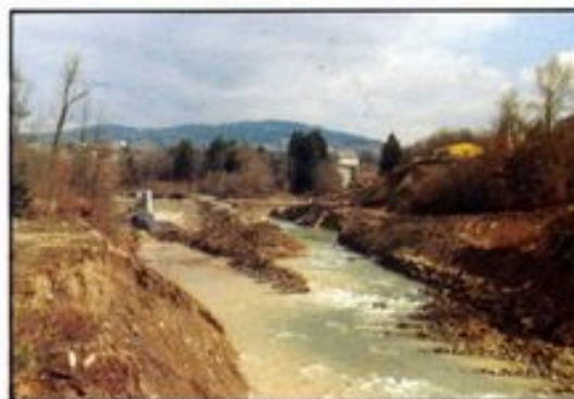
Mars 80 : Basculement de la dérivation rive gauche à la rive droite.
