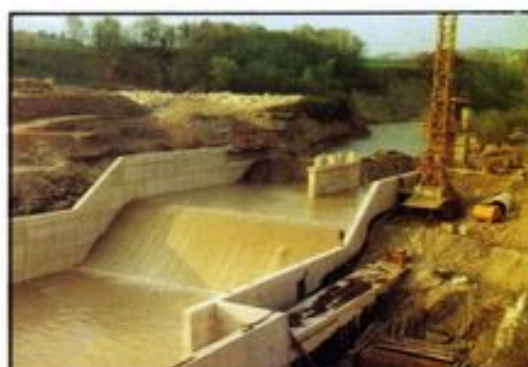
Avril 81 : mise en eau du seuil
