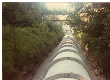
Détail de la conduite forcée se trouvant dans l'ancien canal de fuite Phot. Samir Mahfoudi IVR82_20107400042NUCA
