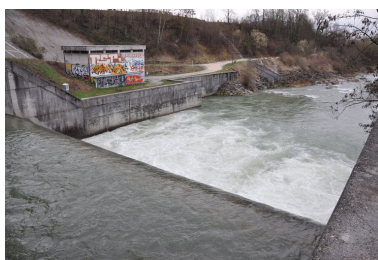
Vue de la centrale d'appoint de la Minoterie Cléchet et du déversoir du pont autoroutier enjambant le Fier Phot. Samir Mahfoudi, Autr. Samir Mahfoudi IVR82_20107400011NUCA
