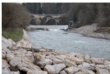
Vue générale du barrage de la prise d'eau de la Minoterie Cléchet en aval du pont des romains et du pont de Brogny Phot. Samir Mahfoudi, Autr. Samir Mahfoudi IVR82_20107400010NUCA
