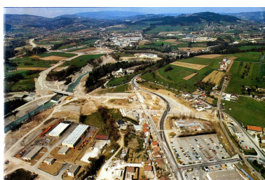
Vue aérienne des travaux du contournement autoroutier nord avec la plate forme de la Minoterie Cléchet prise du sud est Phot. Samir Mahfoudi IVR82_20107400014NUCA
