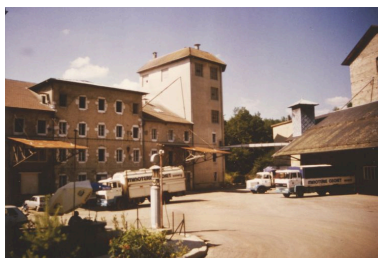
Vue générale de la façade antérieure du bâtiment du moulin et de l'élévation du bâtiment du nettoyage en 1983 Phot. Samir Mahfoudi IVR82_20107400017NUCA
