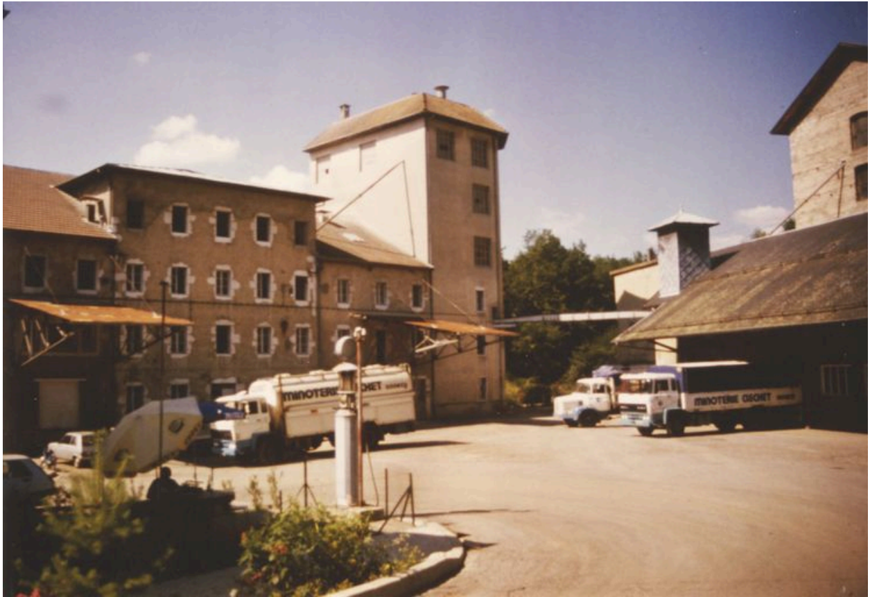
Vue générale de la façade antérieure du bâtiment du moulin et de l'élévation du bâtiment du nettoyage en 1983
