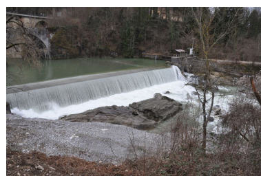
Vue générale de la prise d'eau alimentant le canal d'amenée prise depuis la rive droite du Fier Phot. Samir Mahfoudi, Autr. Samir Mahfoudi IVR82_20107400009NUCA
