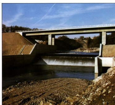
Vue générale du seuil, du barrage du pont autoroutier à la fin des travaux Phot. Samir Mahfoudi IVR82_20107400037NUCA
