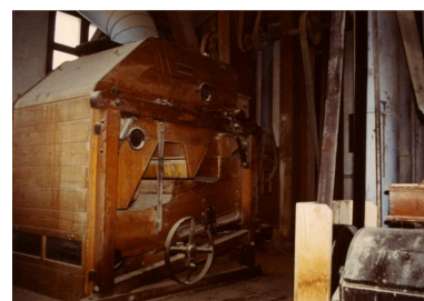
Vue intérieure du bâtiment des silos à grains avant rénovation en 1983 Phot. Samir Mahfoudi IVR82_20107400027NUCA
