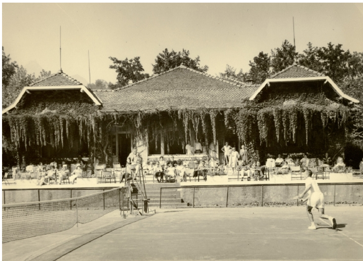
Façade dans la première moitié du XXe siècle
