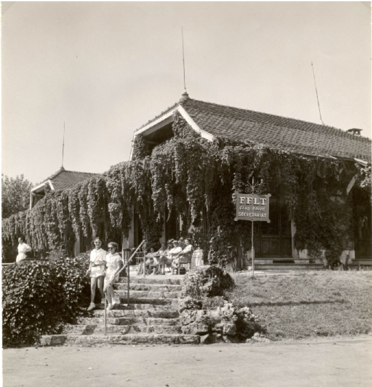
Vue de la façade Nord-est, 1ère moitié XXe siècle
