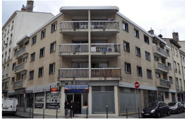
Vue d'ensemble, depuis la rue Basse-Combalot Phot. Catherine Guégan IVR82_20156901021NUCA
