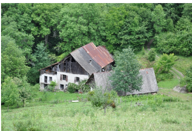
Vue du moulin Phot. Yannick Milleret IVR82_20127301751NUCA
