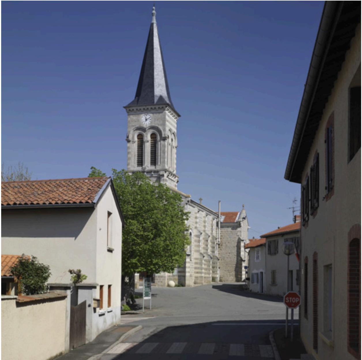
Vue d'ensemble de trois-quarts depuis le sud-ouest.
