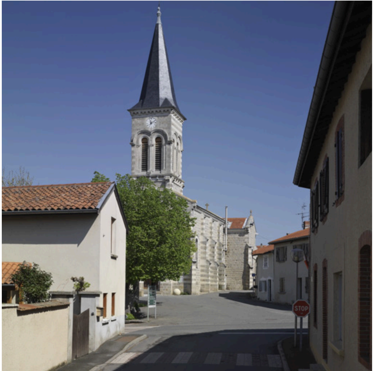
Vue d'ensemble de trois-quarts depuis le sud-ouest.
