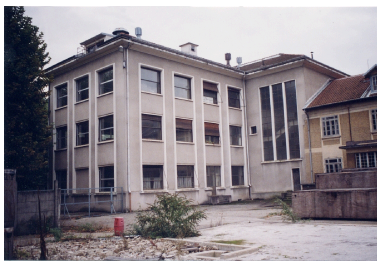
Elévation nord du corps de bâtiment en équerre Repro. François Fouger IVR82_20087300692NUCB
