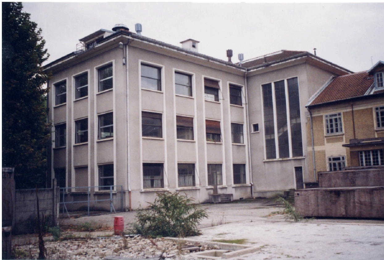
Elévation nord du corps de bâtiment en équerre
