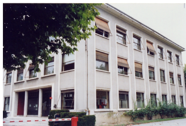
L'entrée principale vue depuis le sud-est Repro. François Fouger IVR82_20087300693NUCB
