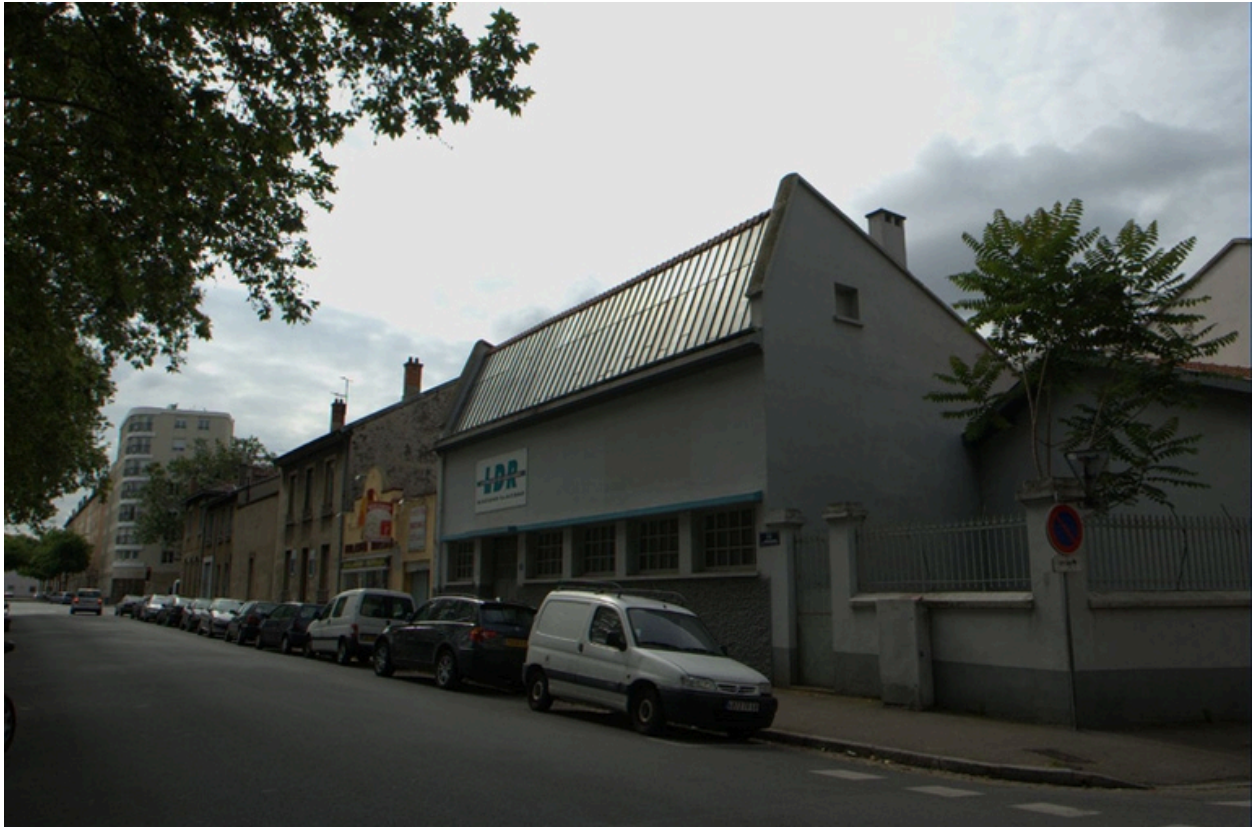
Vue d'ensemble ouest
