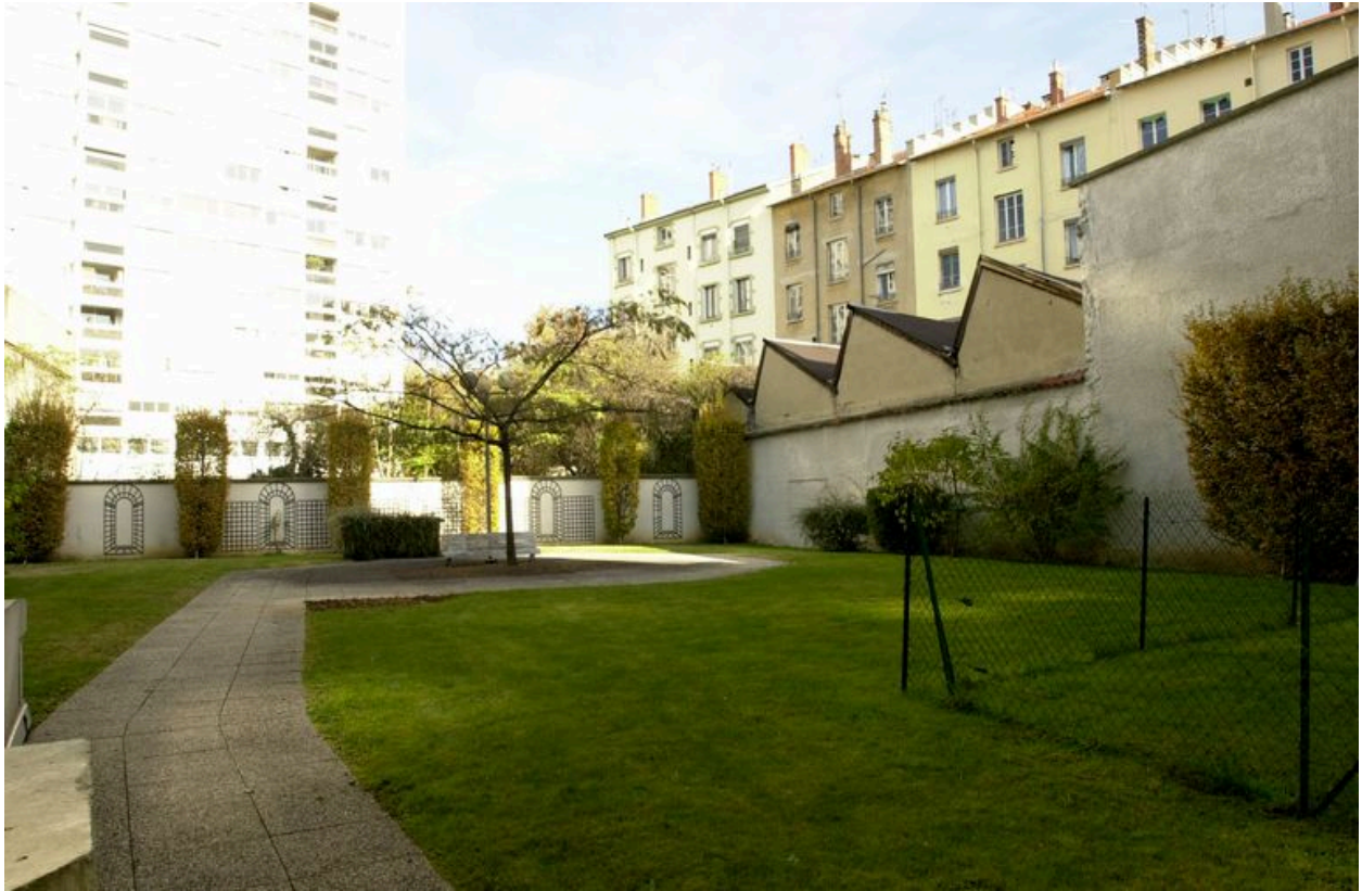
Vue du corps de bâtiment couvert en sheds depuis le sud-ouest
