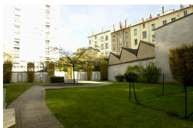
Vue du corps de bâtiment couvert en sheds depuis le sud-ouest Phot. Maryannick Chalabi IVR82_20086900716NUCA
