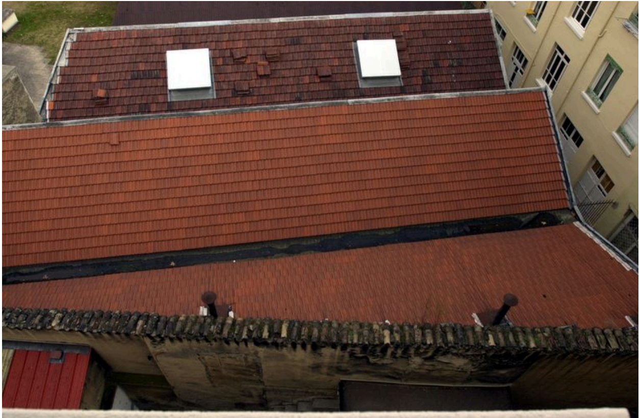
Vue du mur séparant la cour de l'immeuble 3 rue de l'Abbé-Boisard du corps de bâtiment couvert en sheds
