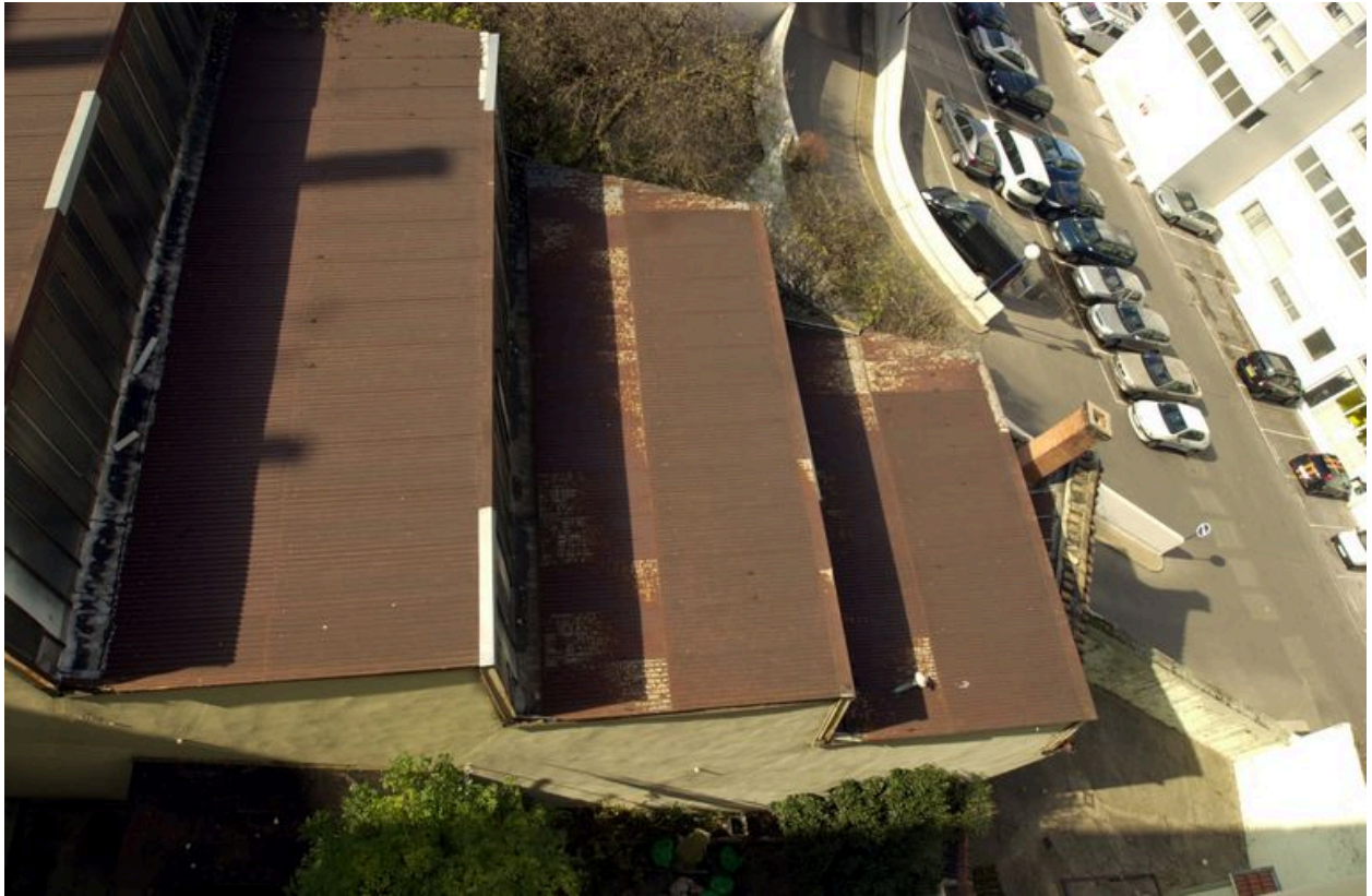
Extrémité nord du bâtiment couvert en sheds depuis l'est
