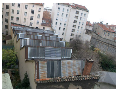
Vue de l'élévation postérieure et du bâtiment couvert en sheds construit à l'arrière Phot. Maryannick Chalabi IVR82_20086900615NUCA
