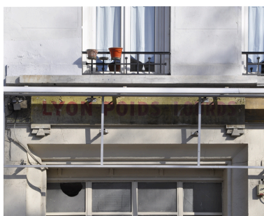
Détail d'une ancienne enseigne sur la façade (2012) Phot. Catherine Guégan IVR82_20126902411NUCA
