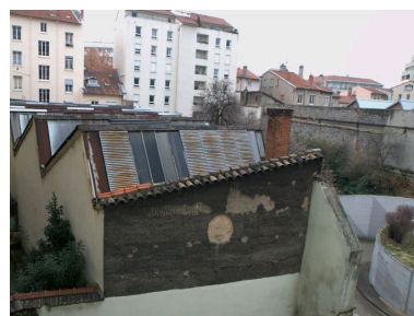
Vue d'ensemble du bâtiment couvert en sheds depuis le nord Phot. Maryannick Chalabi IVR82_20086900721NUCA
