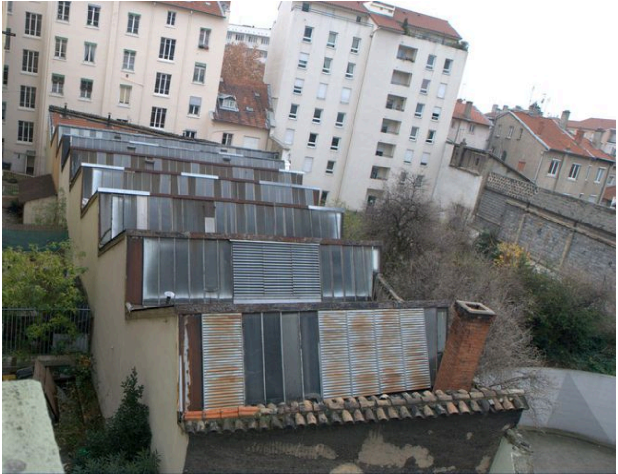
Vue de l'élévation postérieure et du bâtiment couvert en sheds construit à l'arrière
