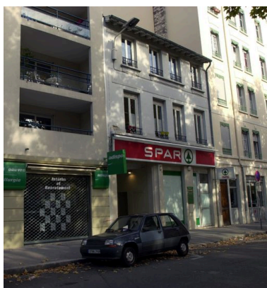
Élévation principale depuis le sud-ouest Phot. Maryannick Chalabi IVR82_20086900613NUCA
