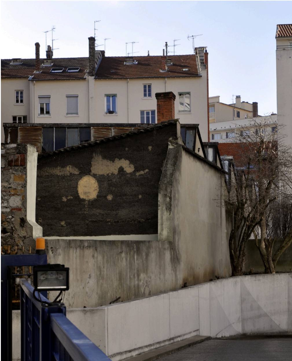
Vue d'ensemble du bâtiment couvert de sheds depuis le nord-ouest
