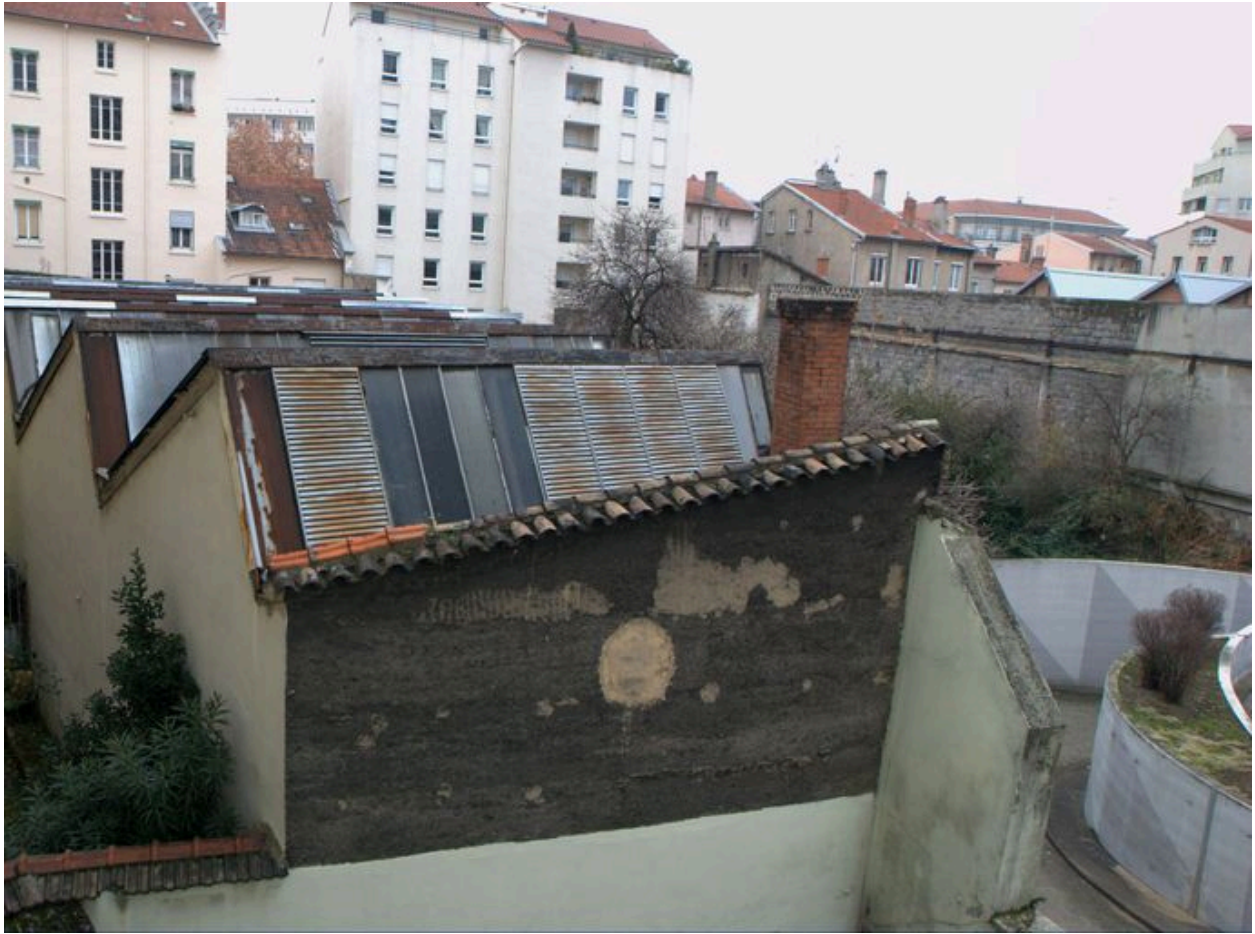
Vue d'ensemble du bâtiment couvert en sheds depuis le nord
