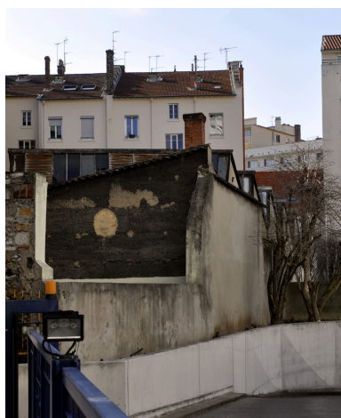
Vue d'ensemble du bâtiment couvert de sheds depuis le nord-ouest Phot. Catherine Guégan IVR82_20126902407NUCA
