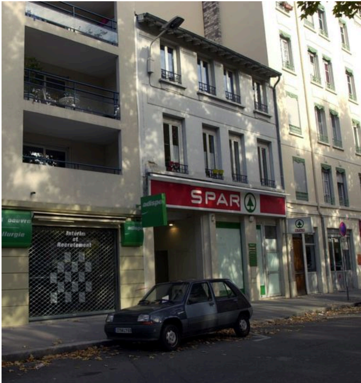
Elévation principale depuis le sud-ouest
