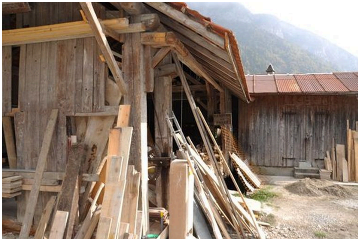
Chantier de la scierie
