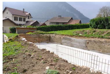
Bassin de retenue Phot. Samir Mahfoudi, Autr. Samir Mahfoudi IVR82_20107403147NUCA
