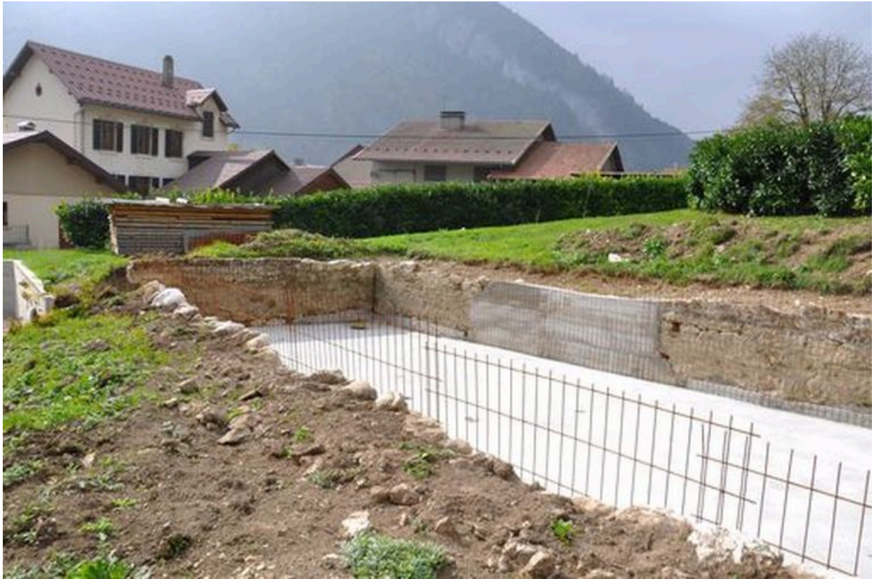
Bassin de retenue
