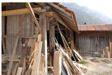
Chantier de la scierie Phot. Samir Mahfoudi, Autr. Samir Mahfoudi IVR82_20107403152NUCA
