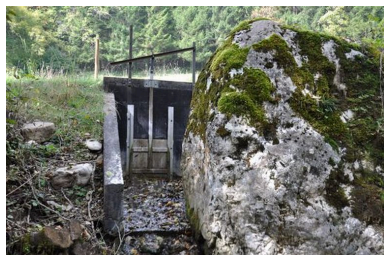
Vanne régulant le trop plein Phot. Samir Mahfoudi, Autr. Samir Mahfoudi IVR82_20107403145NUCA
