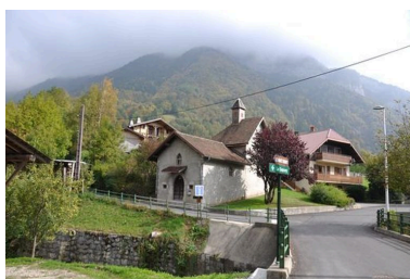
Vue de la Chapelle de Thuy prise depuis la propriété du moulin Phot. Samir Mahfoudi, Autr. Samir Mahfoudi IVR82_20107403149NUCA
