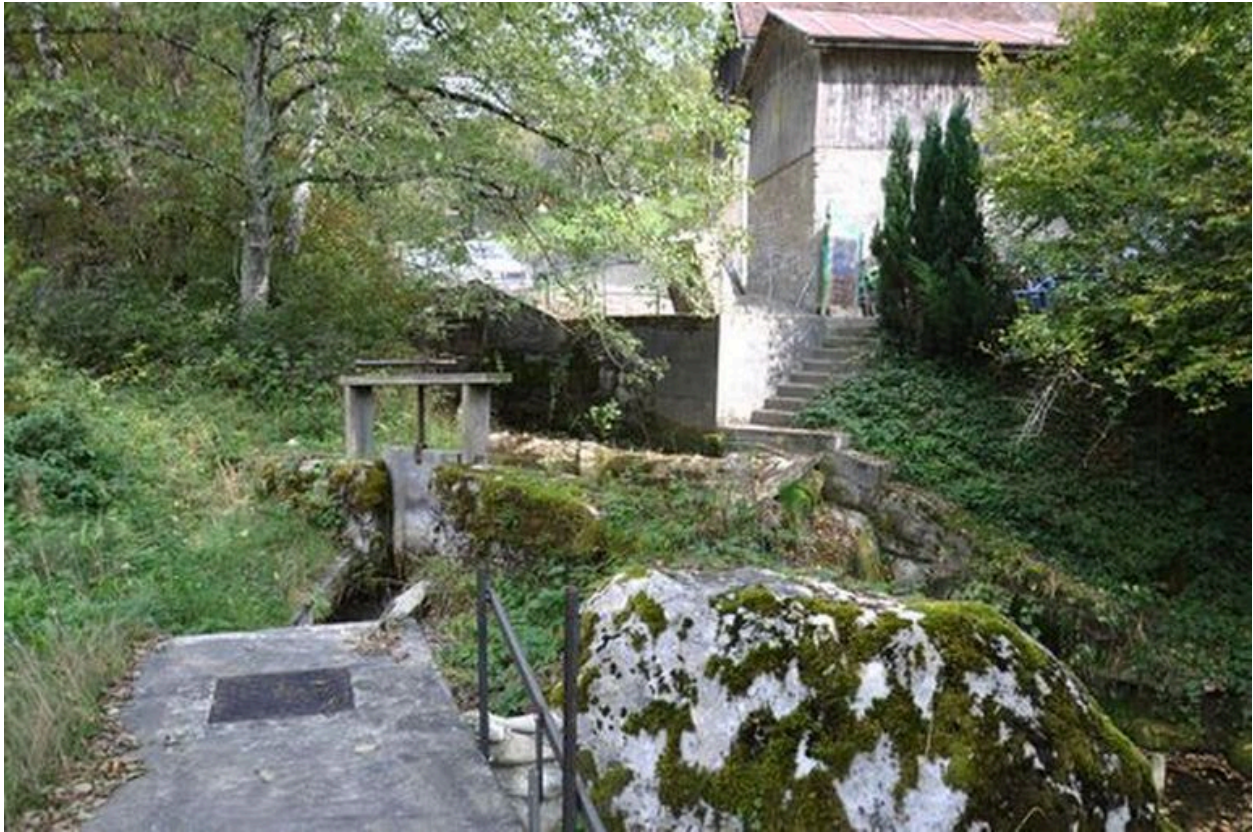
Vanne alimentant la prise d'eau de l'huilerie
