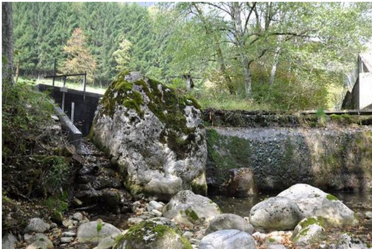
Seuil du barrage
