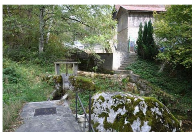
Vanne alimentant la prise d'eau de l'huilerie Phot. Samir Mahfoudi, Autr. Samir Mahfoudi IVR82_20107403143NUCA
