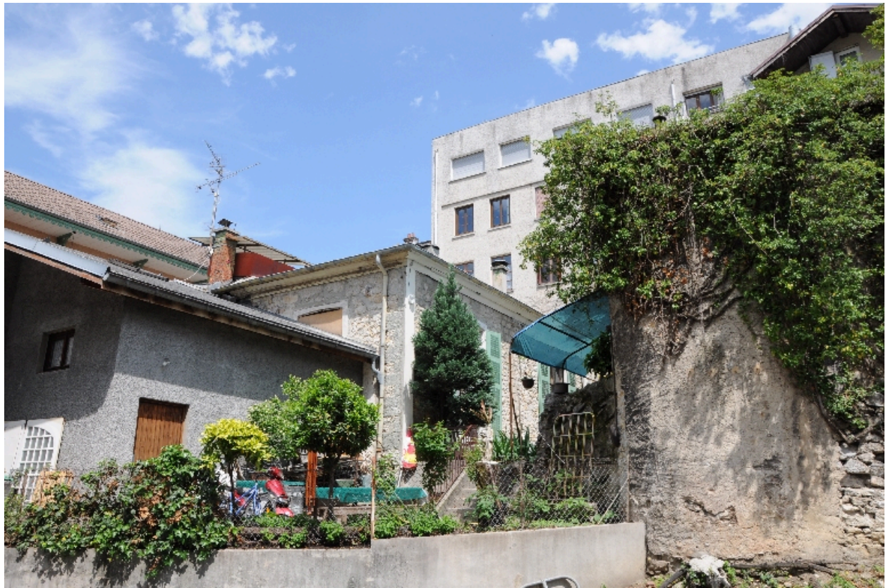
Elévation postérieure et bâtiments annexes
