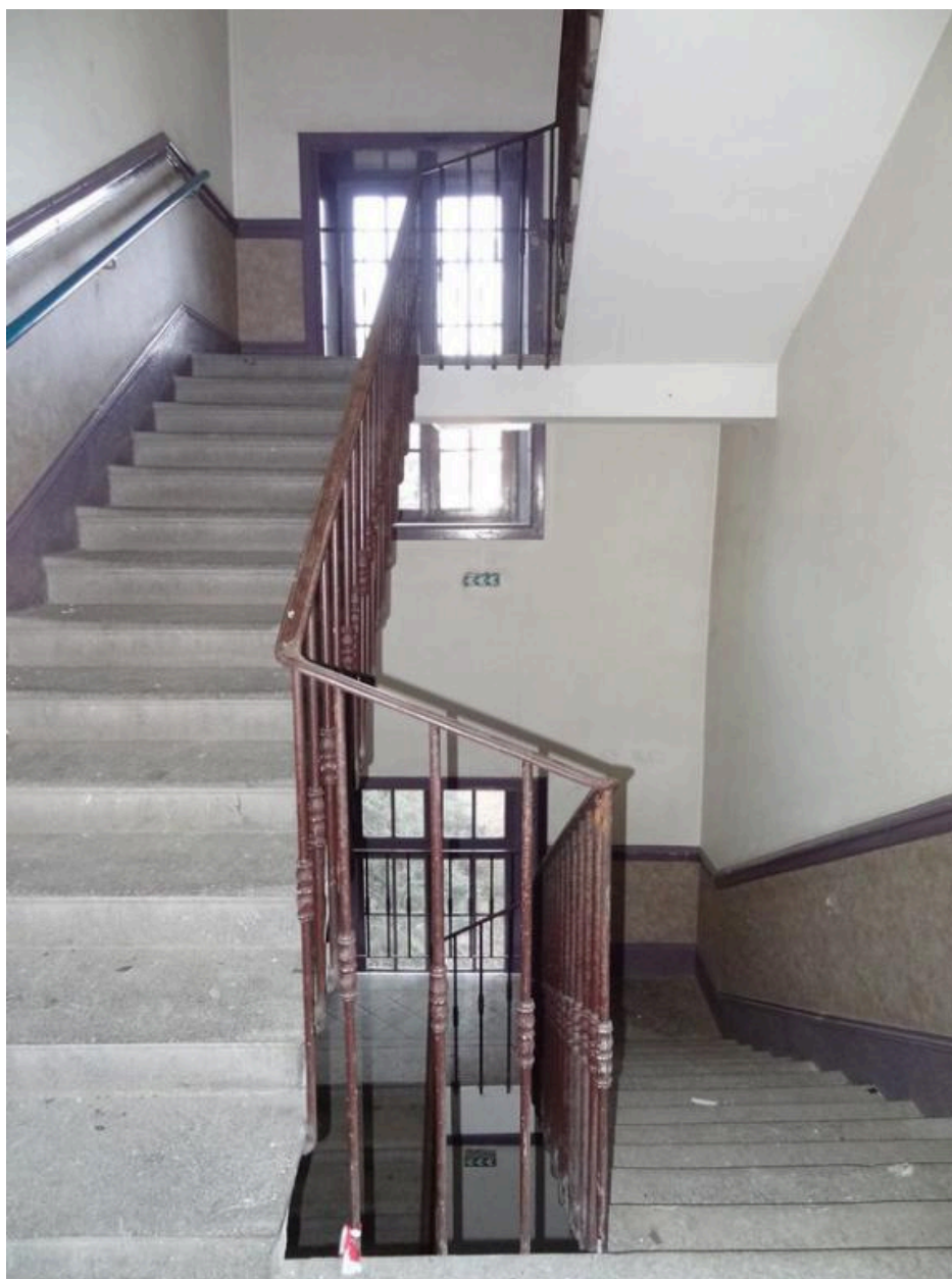
Escalier situé dans l'angle nord-est du bâtiment principal.
