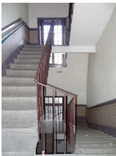
Escalier situé dans l'angle nord-est du bâtiment principal. Phot. Bénédicte Renaud-Morand IVR84_20196300034NUCA
