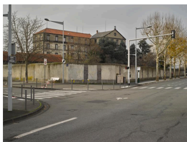
Vue générale du noviciat depuis l'avenue de la République. Phot. Christian Parisey IVR84_20186300103NUC4A
