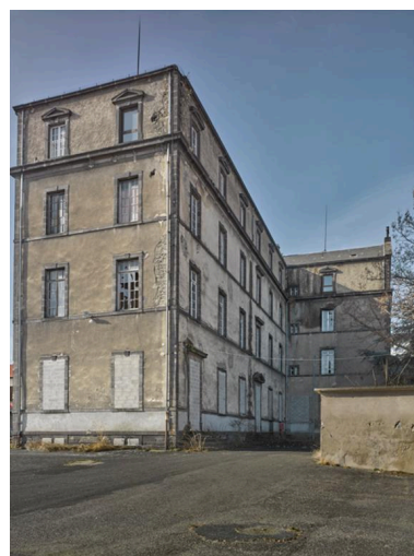
Vue depuis le nord-est, à l'intérieur de l'enclos. Phot. Christian Parisey IVR84_20196300003NUC4A
