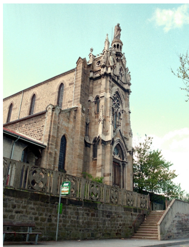
Façade principale, sur la place, au nord Phot. Cendrine Sanquer IVR82_19974201964ZE
