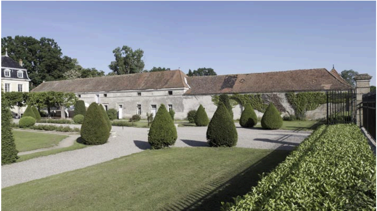
Vue de l'aile sud, élévation nord, depuis le nord-ouest.
