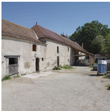
Vue de l'aile sud, élévation sud, depuis le sud-ouest (état avant travaux). Phot. Didier Gourbin IVR82_20054202045NUCA
