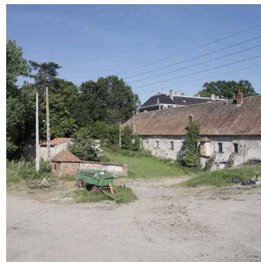
Vue de l'aile nord, partie est de l'élévation nord, depuis le nord-ouest. Phot. Didier Gourbin IVR82_20054202035NUCA
