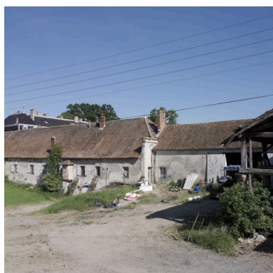
Vue de l'aile nord, partie ouest de l'élévation nord, depuis le nord-ouest. Phot. Didier Gourbin IVR82_20054202036NUCA
