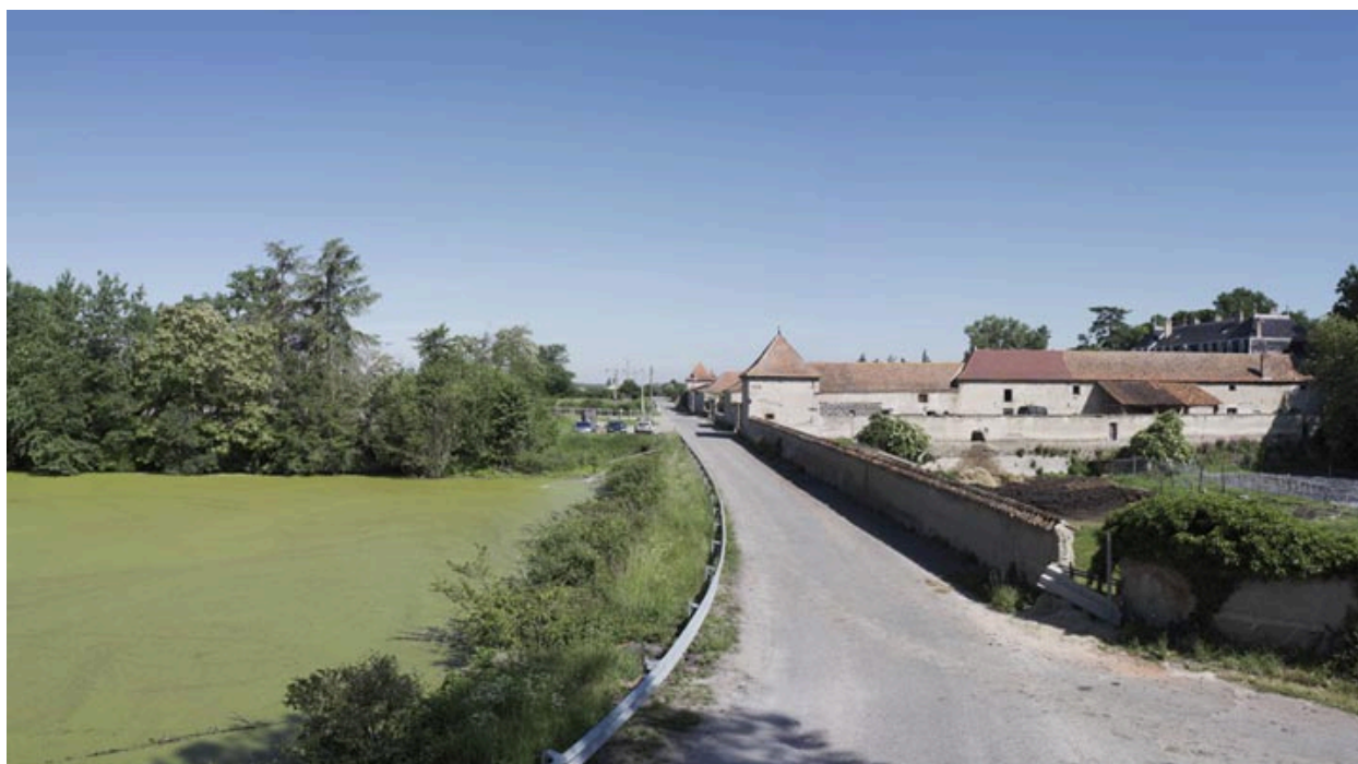
Vue générale depuis le sud (état en 2005).
