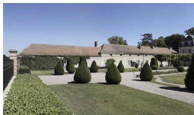
Vue d'ensemble de l'aile nord, depuis le sud-ouest. Phot. Didier Gourbin IVR82_20054202019NUCAQ
