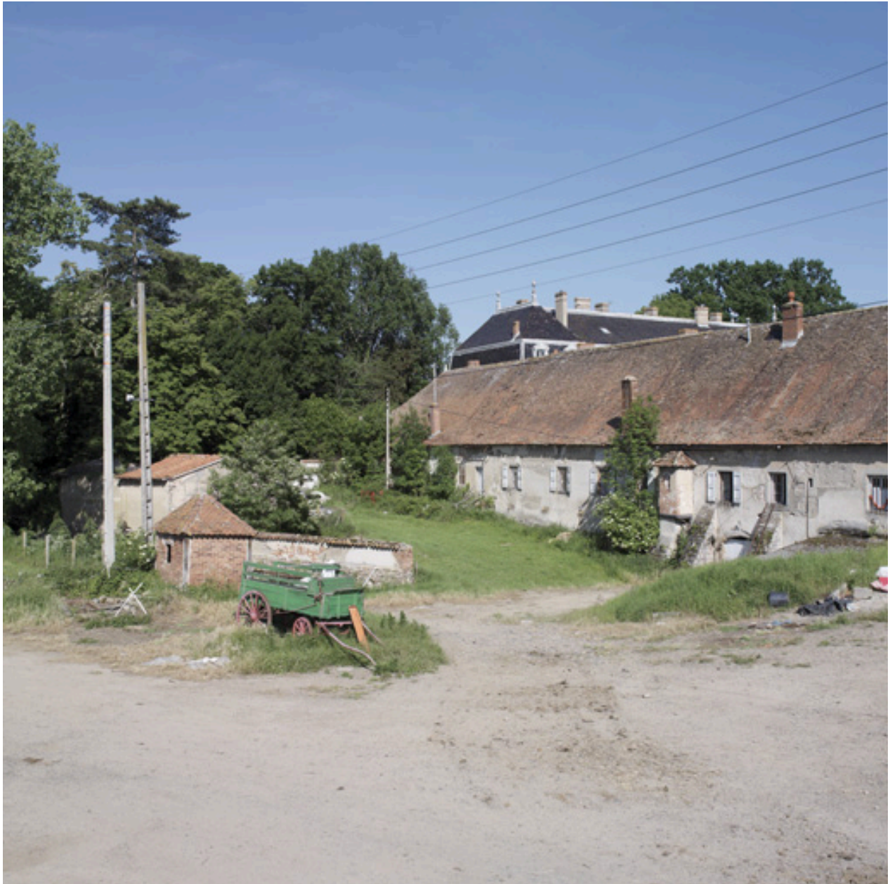
Vue de l'aile nord, partie est de l'élévation nord, depuis le nord-ouest.
