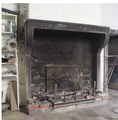
Vue intérieure de l'aile nord, cheminée du relais de chasse. Phot. Didier Gourbin IVR82_20054202041NUCA
