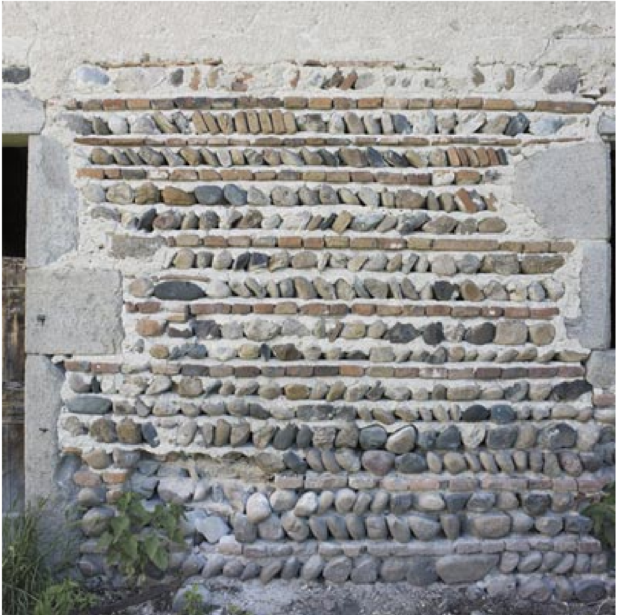
Détail de maçonnerie de galets sur la petite remise ou étable à l'angle sud-est de la cour sud des communs.
