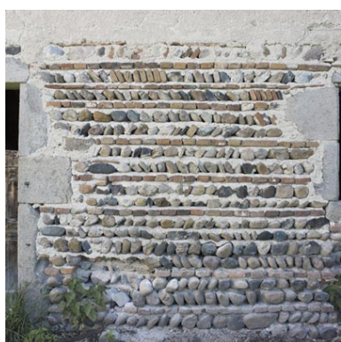
Détail de maçonnerie de galets sur la petite remise ou étable à l'angle sud-est de la cour sud des communs. Phot. Didier Gourbin IVR82_20054202050NUCA
