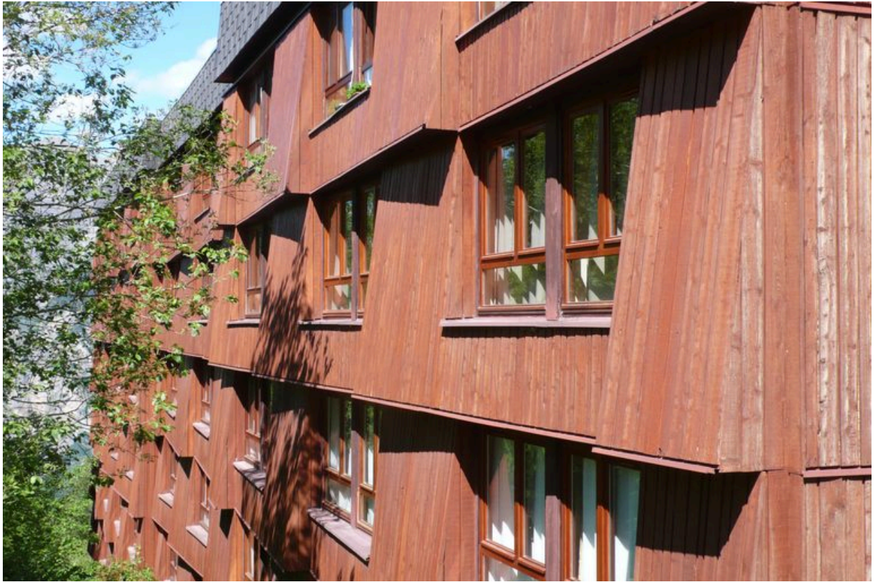
Détail de la structure de la façade
