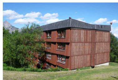
Le pignon sud Phot. Jean-François Lyon-Caen IVR82_20127302501NUCA
