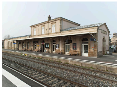
Vue générale de la gare d'Issoire, côté voies. Phot. Jean-Michel Périn IVR83_20156300313NUC4A
