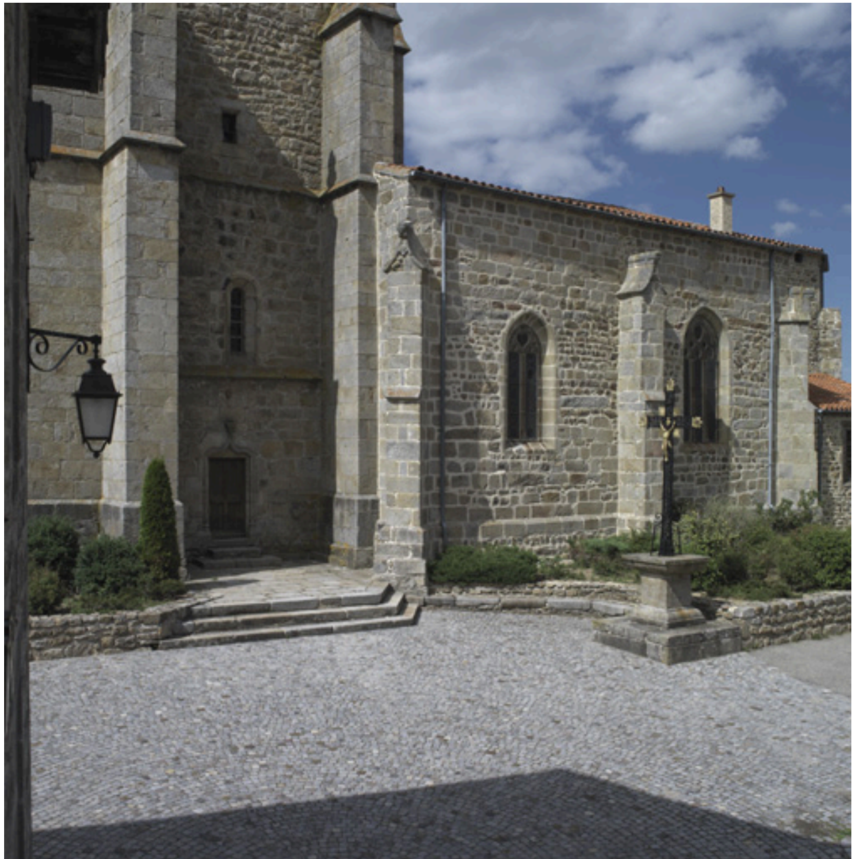
Vue partielle de l'élévation sud de l'église.
