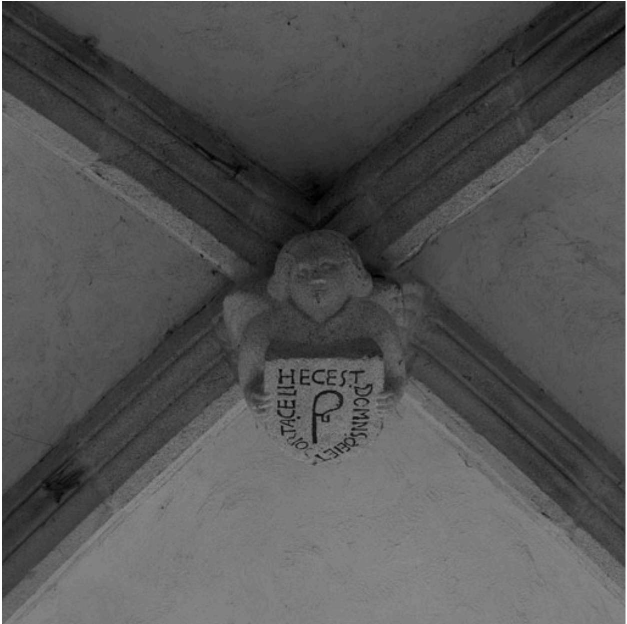
Vue d'ensemble de la clef de voûte située dans la seconde travée de la nef.
