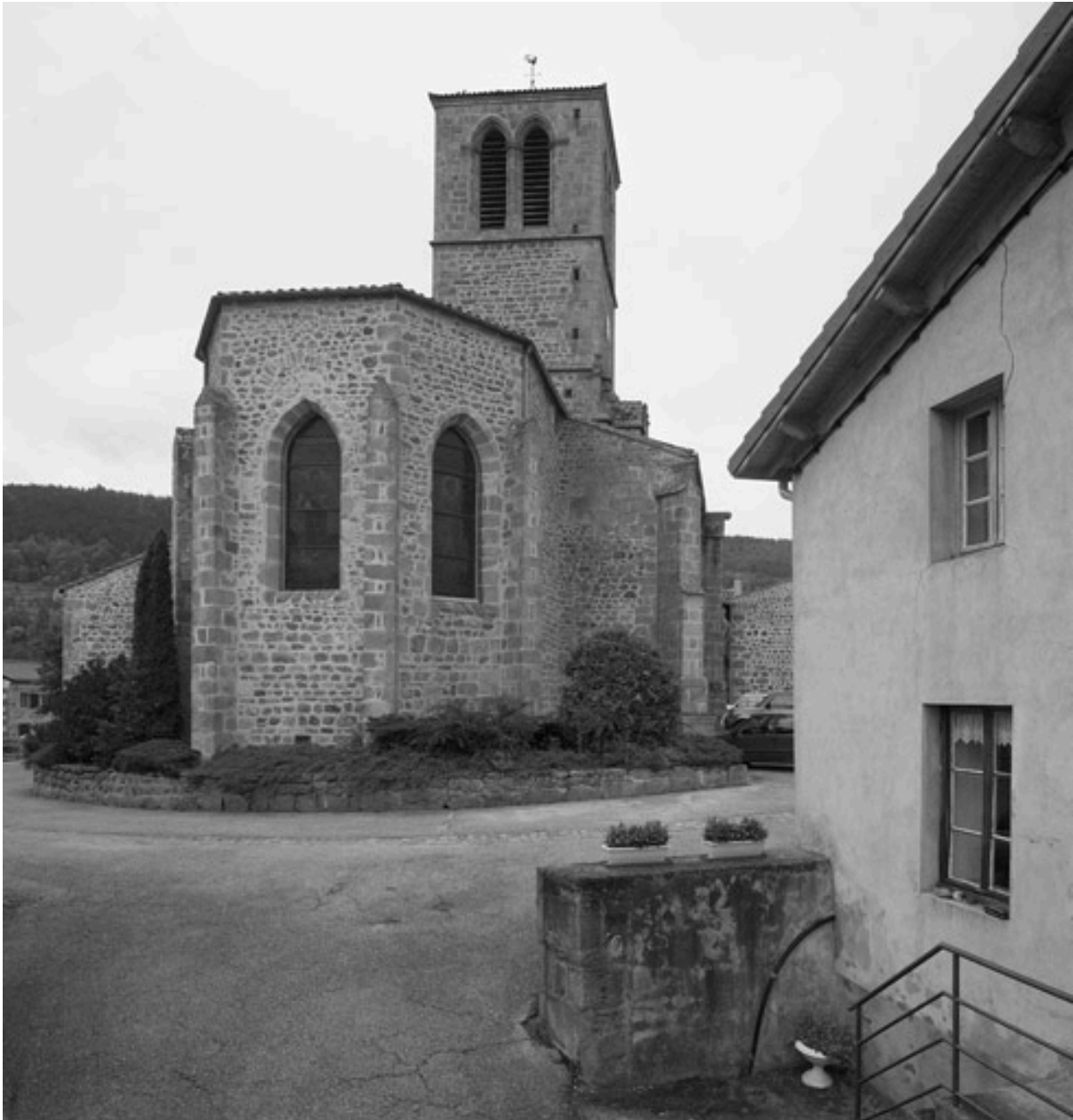
Vue d'ensemble du chevet de l'église.
