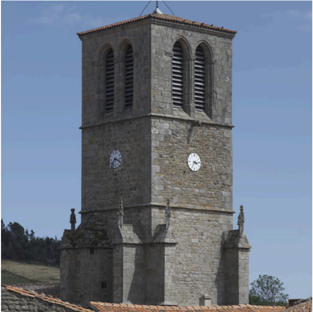
Vue d'ensemble de trois quarts de la partie haute du clocher.
