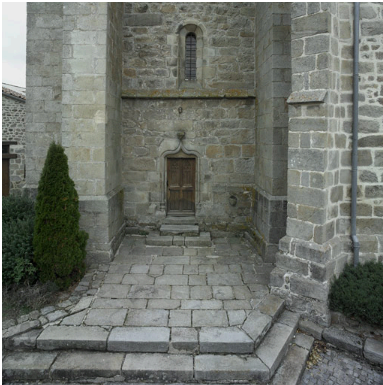
Vue partielle du clocher, côté sud, avec la porte latérale ouvrant anciennement sur le cimetière.
