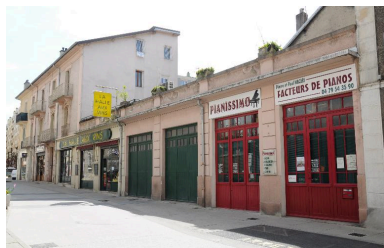
Vue d'ensemble : immeuble, boutiques et garages Phot. Denys Harreau IVR82_20147300338NUCA
