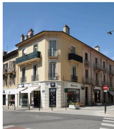
Vue d'ensemble de l'immeuble Phot. Denys Harreau IVR82_20147300336NUCA
