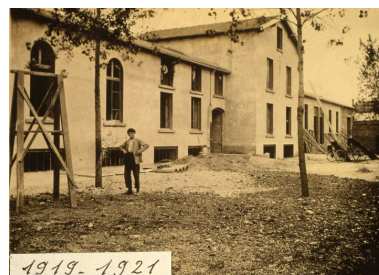
1919-1921 Les ateliers en cours de construction, vers 1920 Repro. Maryannick Chalabi IVR82_20106903452NUCB
