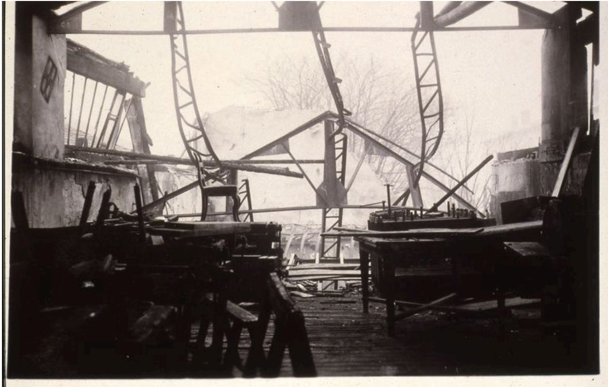
Les ateliers détruits par l'incendie de 1942
