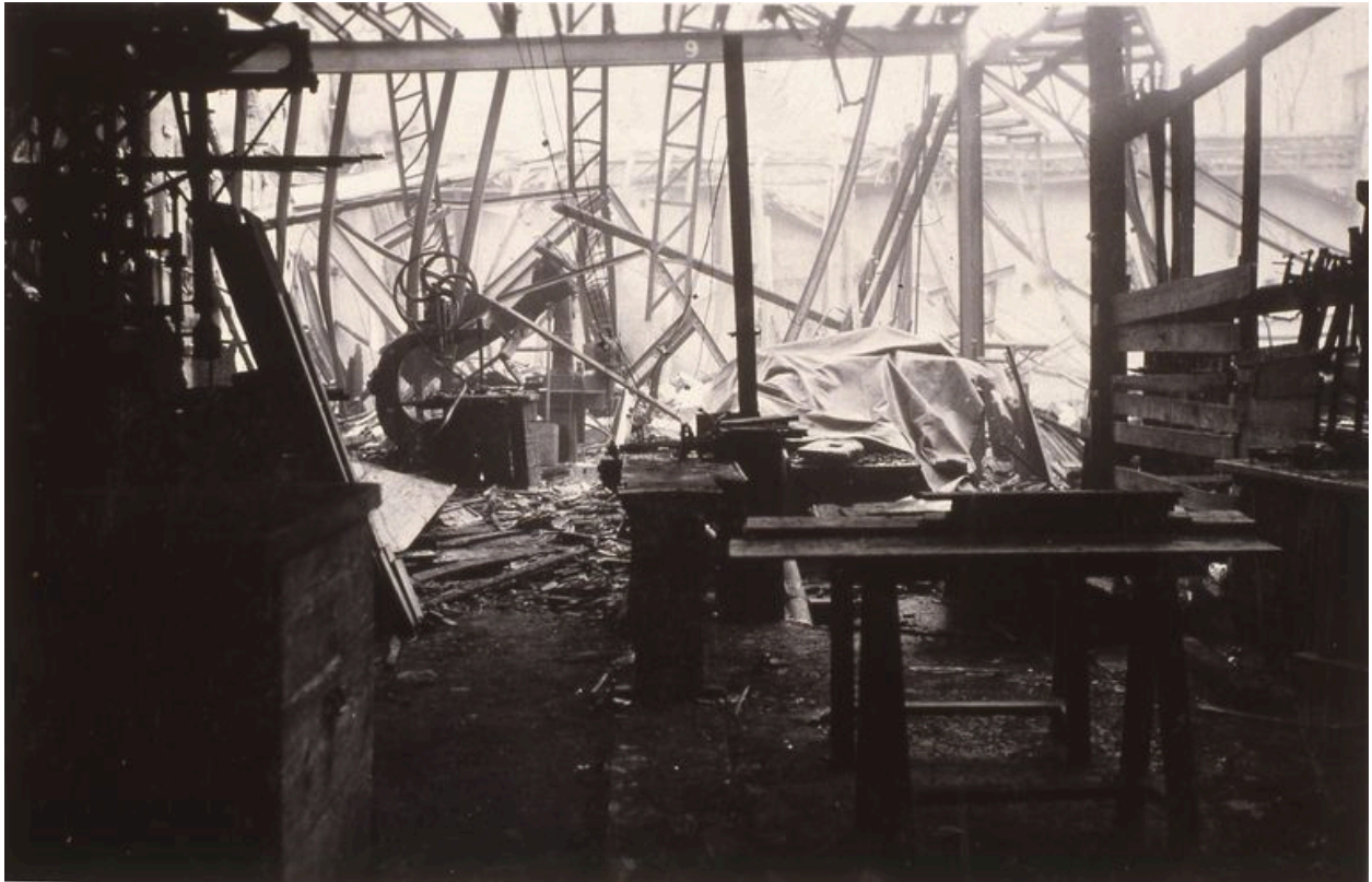
Les ateliers détruits par l'incendie de 1942
