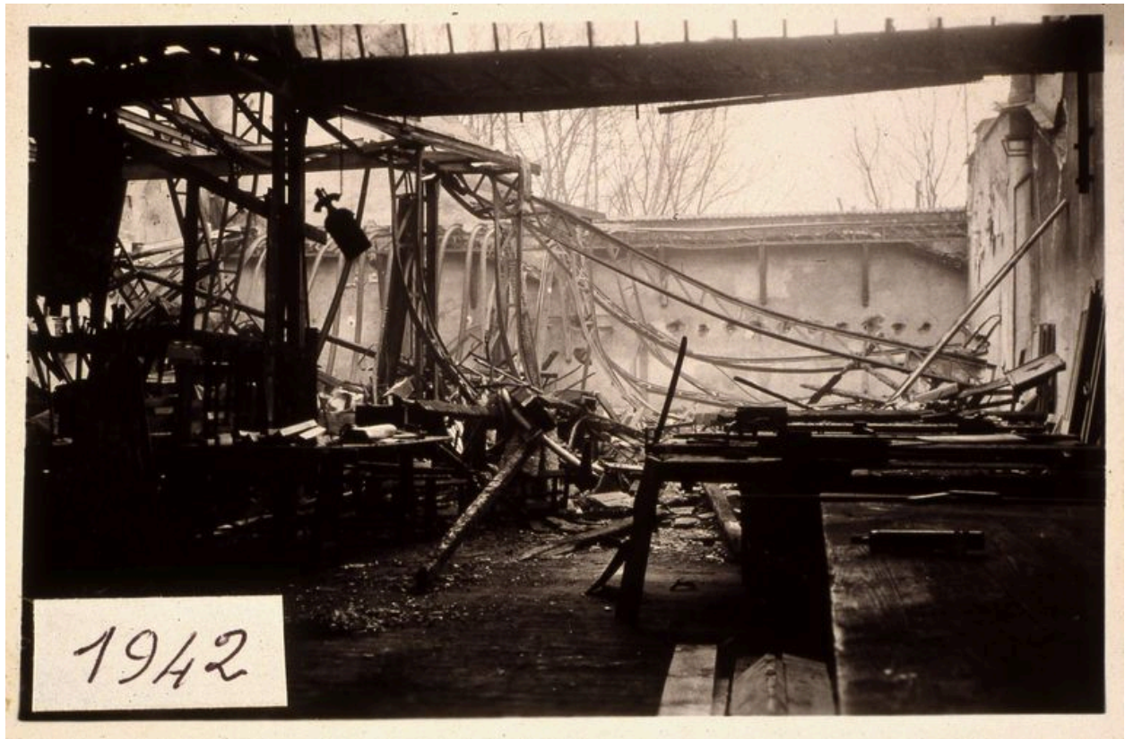
Les ateliers détruits par l'incendie de 1942
