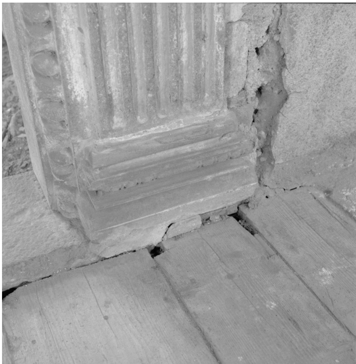
Corps de logis, 2e étage, porte de la grande chambre ouvrant sur le corridor : détail de la base du piédroit.
