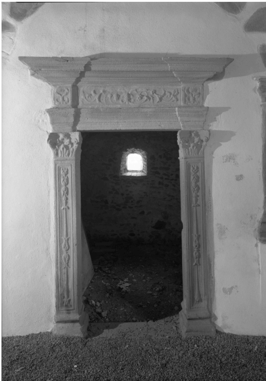
Vue de la porte située sous la rampe du corps de galerie.
