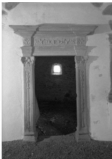
Vue de la porte située sous la rampe du corps de galerie. Phot. Jean-Marie Refflé IVR82_20014201305P
