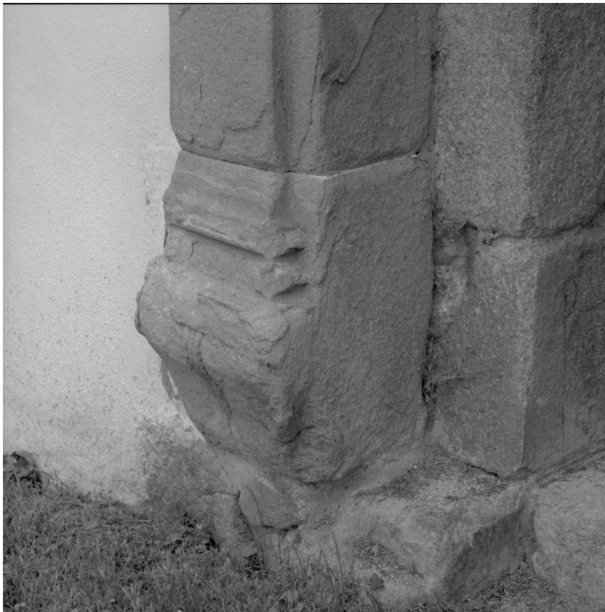
Bastion sud-ouest : base du piédroit gauche de la porte ouvrant sur le jardin.
