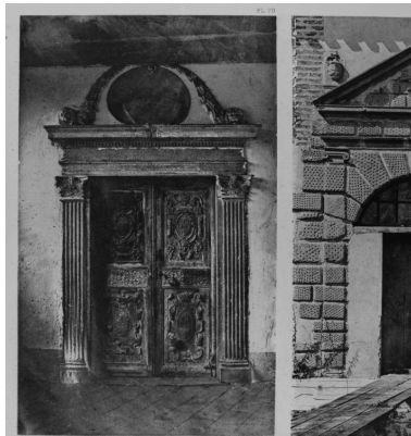
Vue de la porte située dans la galerie et ouvrant sur l'entrée du corps de logis, en 1858. Repro. Martial Couderette, Autr. Félix (photographe) Thiollier IVR82_20004201712XB
