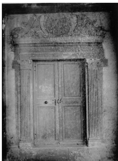
Vue de la deuxième porte de la grande pièce ("grand salon") ouvrant sur la galerie, dans la 2e moitié du XIXe siècle. Repro. Martial Couderette, Autr. Félix (photographe) Thiollier IVR82_20014201307XB
