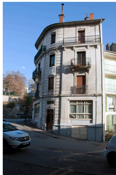
Vue prise depuis l'ouest Phot. Denys Harreau IVR84_20177300495NUCA
