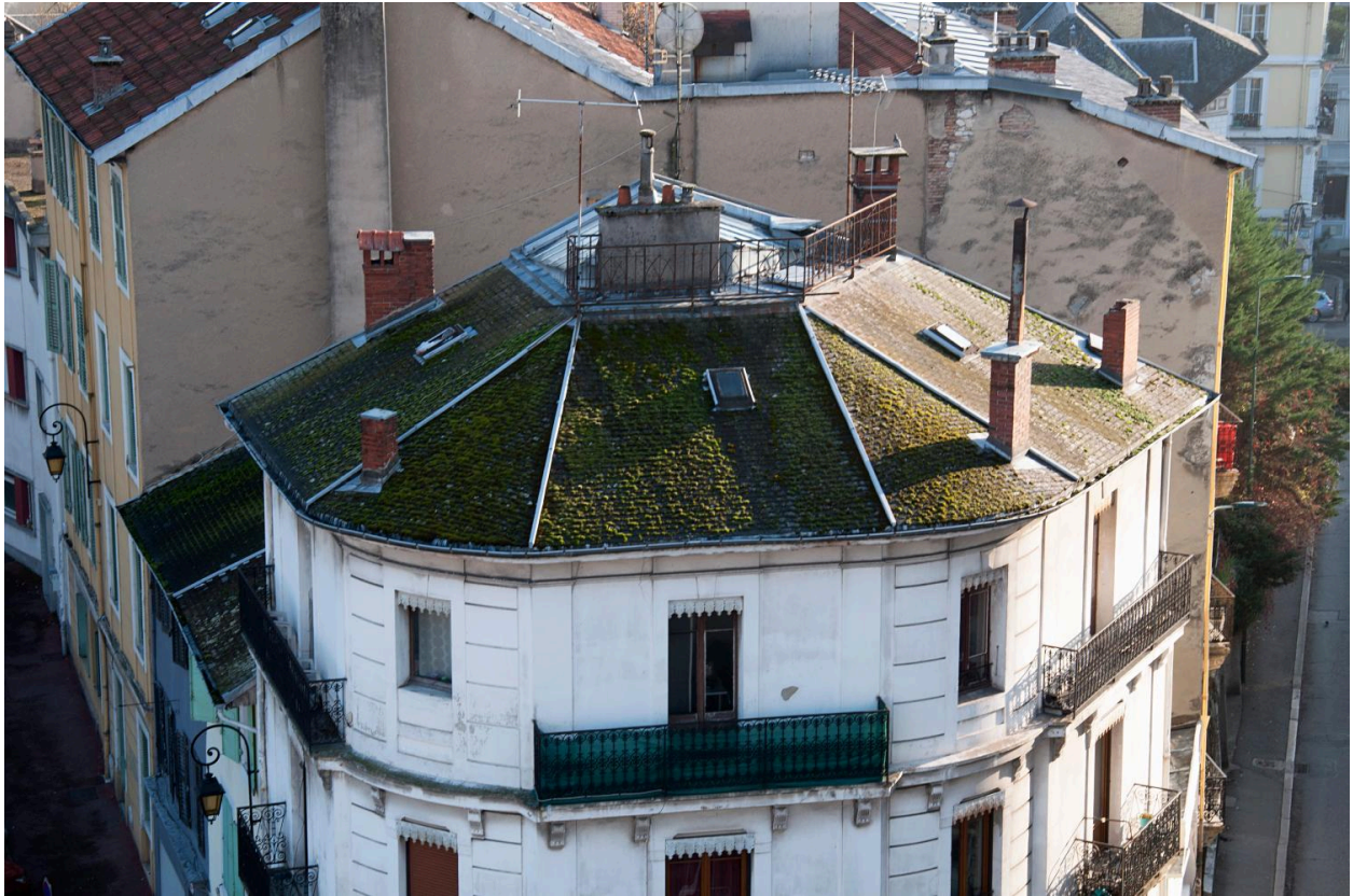
Les toitures et la verrière zénithale de la cage d'escalier centrale
