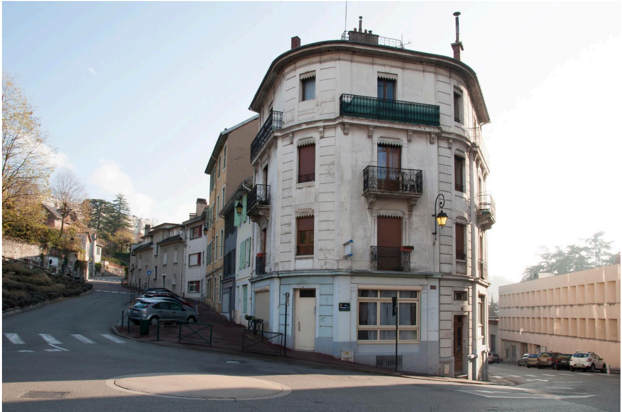
Vue prise depuis la place Ingénieur François
