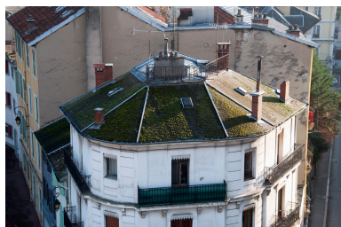
Les toitures et la verrière zénithale de la cage d'escalier centrale Phot. Denys Harreau IVR84_20177300496NUCA
