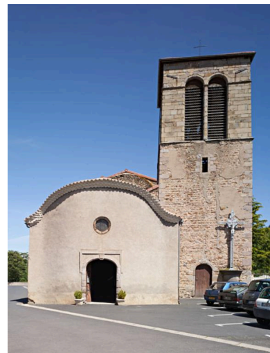
Vue de la façade occidentale. Phot. Jean-Michel Périn IVR83_20146300346NUC4A
