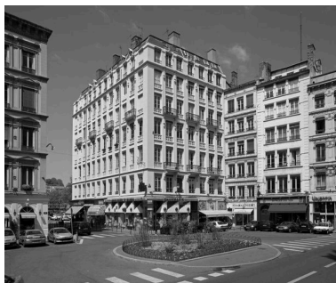
Vue générale de situation Phot. Eric Dessert IVR82_20056901709NUC
