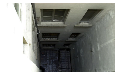
Cour à l'arrière du 1er corps de bâtiment prise depuis l'escalier. A droite, corps de galeries aux ouvertures murées séparant les deux cours Phot. Lore Derail IVR82_20046900087NUCA
