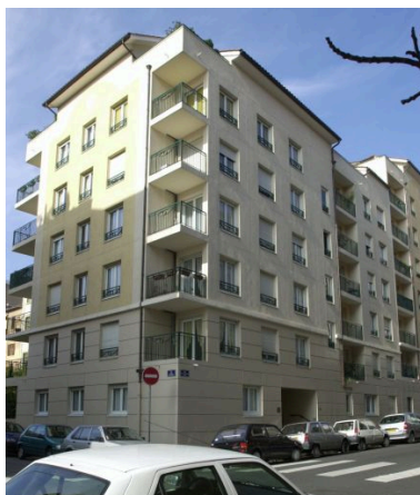
Vue de l'angle des rues Marc-Antoine-Petit et Quivogne depuis le nord-ouest Phot. Chantal Archer-Galéa IVR82_20016901713NUCA
