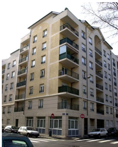
Vue d'ensemble à l'angle de la rue Smith et de la rue Marc- Antoine-Petit depuis le nord-est Phot. Chantal Archer-Galéa IVR82_20016901712NUCA
