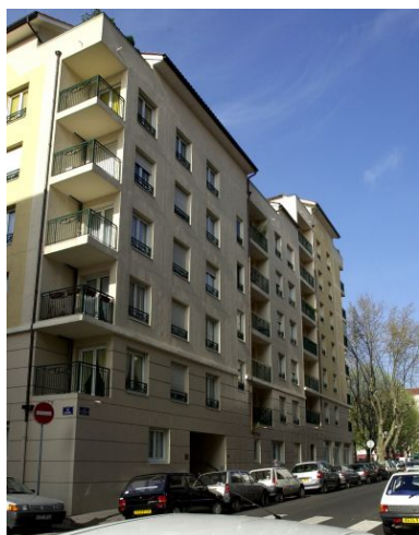
Elévation rue Marc-Antoine-Petit Phot. Chantal Archer-Galéa IVR82_20016901714NUCA
