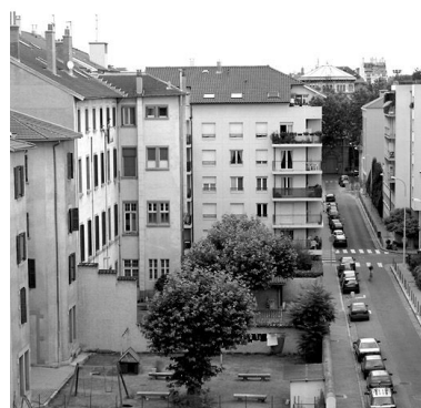
Elévation sud Phot. Eric Dessert IVR82_20016902928X
